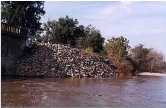
**Figura I.3.-** Protección con enrocado. Estribo de margen izquierda del puente de la R.P. N° 4 (Río Salado). Santa Fe. Argentina
