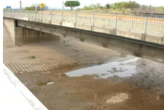
**Figura I.4.-** Protección con bloques de hormigón adheridos a geotextil. Aliviador Ruta Nacional 168. Santa Fe. Argentina
