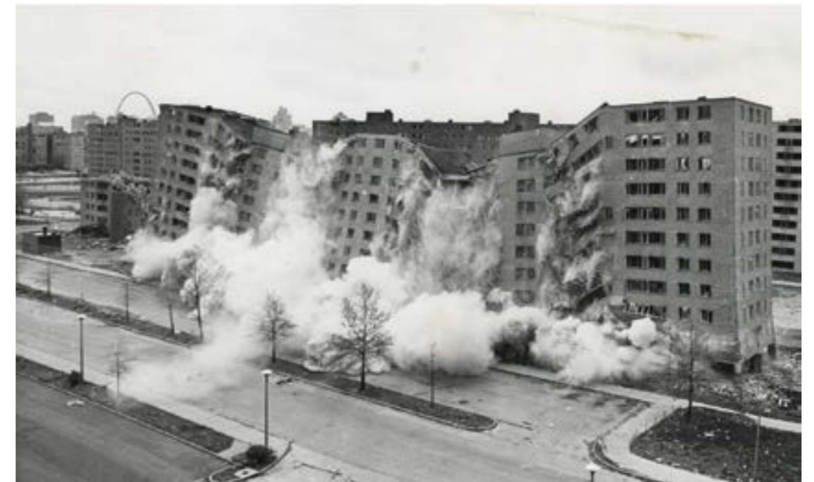
Fig.III-01. Pruitt Igoe, demolición. (1972)
