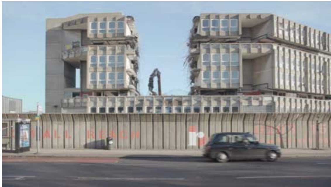
Fig.III-02. Robin Hoods Gardens, comienzo demolición agosto 2017.
