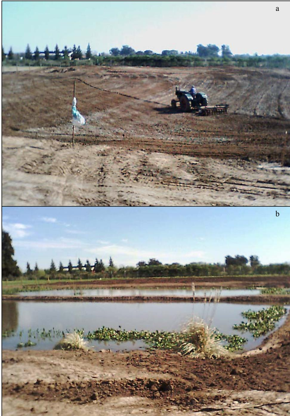
Fig. 3.3. Aspecto que presentó el humedal definitivo durante la etapa de su construcción. En (a) se observa el proceso de compactamiento de la bentonita y en (b) el período de llenado y transplante de la vegetación.
