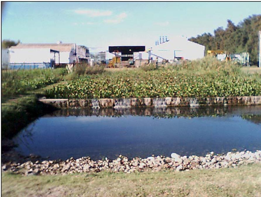
Fig. 3.7. Aspecto que presentó la zona de la salida del humedal definitivo después de que se realizó la extracción de material orgánico del fondo y se construyó una pared para producir una caída de agua y favorecer la aireación en el mes de enero de 2004.
