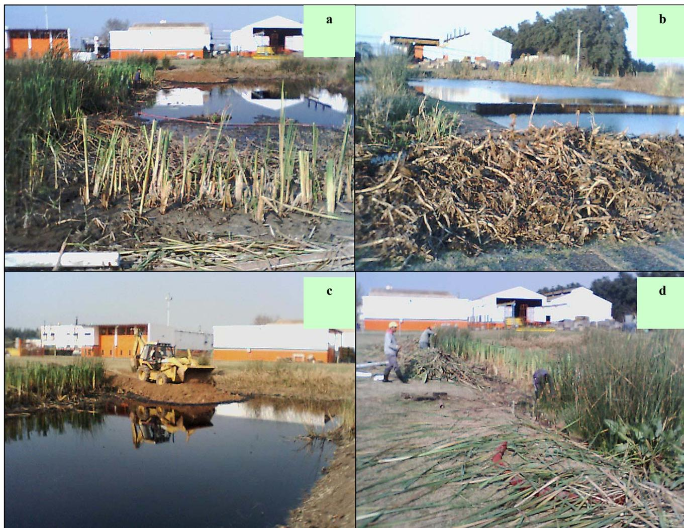
Fig. 3.8. Modificaciones realizadas en el humedal definitivo durante los meses de julio y agosto de 2004. (a) Vaciado y extracción de material orgánico del fondo y poda de plantas de *T. domingensis*. (b) Vista del material vegetal extraído. (c) Construcción de nuevos tabiques transversales al sentido de circulación del agua. (d) Plantación de nuevas plantas de *T. domingensis* en la zona de los bordes y en los tabiques construidos.
