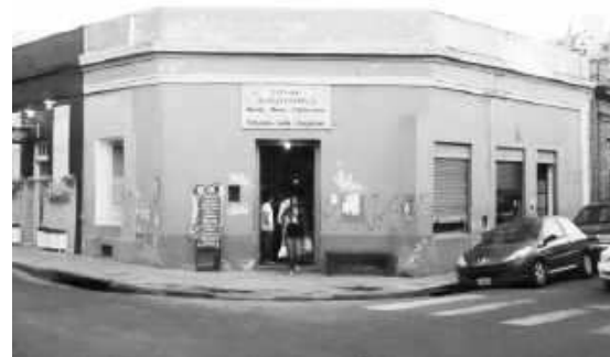
Fig.093. Una vivienda en esquina, combina la actividad residencial y comercial dotando de usos intenso la calle. Fuente: Fotografía propia.
