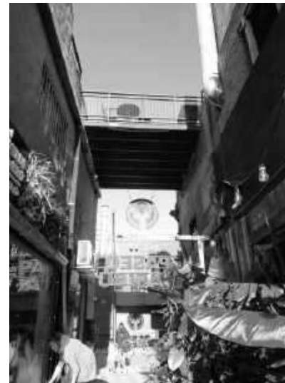
Fig.097. La planta baja alberga los usos públicos mientras que las viviendas se disponen en las plantas altas balconeadas al espacio colectivo. Fuente: Fotografías propias.
