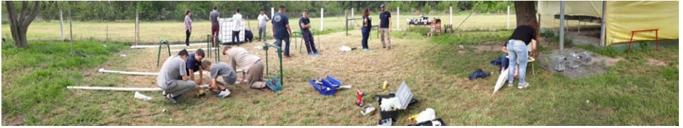
Imagen 9. Construcción del sistema acuapónico en la Escuela de Agricultura, Ganadería y Granja.
