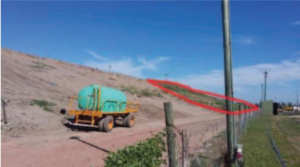
Fig. 4. Vista del relleno sanitario donde se observa un sector correspondiente a la etapa final con vegetación (línea roja).
