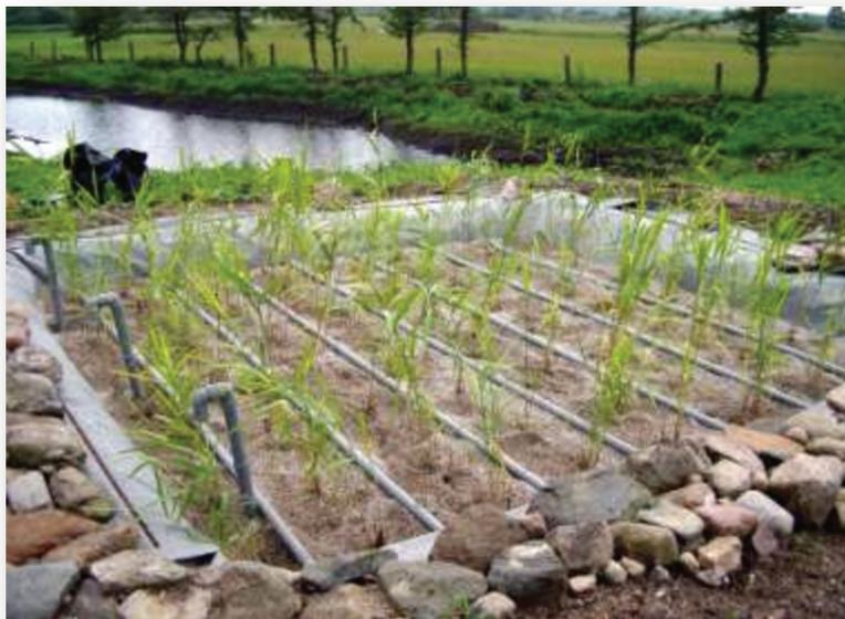
Fig. 7. Esquema de un Humedal de Flujo Vertical (HFV - arriba) y vista de un HFV real (abajo). Foto superior Extraído de URL:
