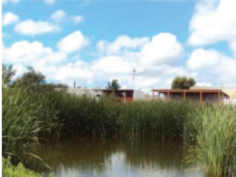
Fig. 5. Esquema de Humedal de Flujo Libre (HFL - arriba) y vista de un HFL real construido para el tratamiento de un efluente de una industria metalúrgica (abajo). Foto superior Extraído de URL: <https://repository.javeriana.edu.co/bitstream/handle/10554/16786/CorralesDuqueAlejandra2015.pdf?sequence=1>
