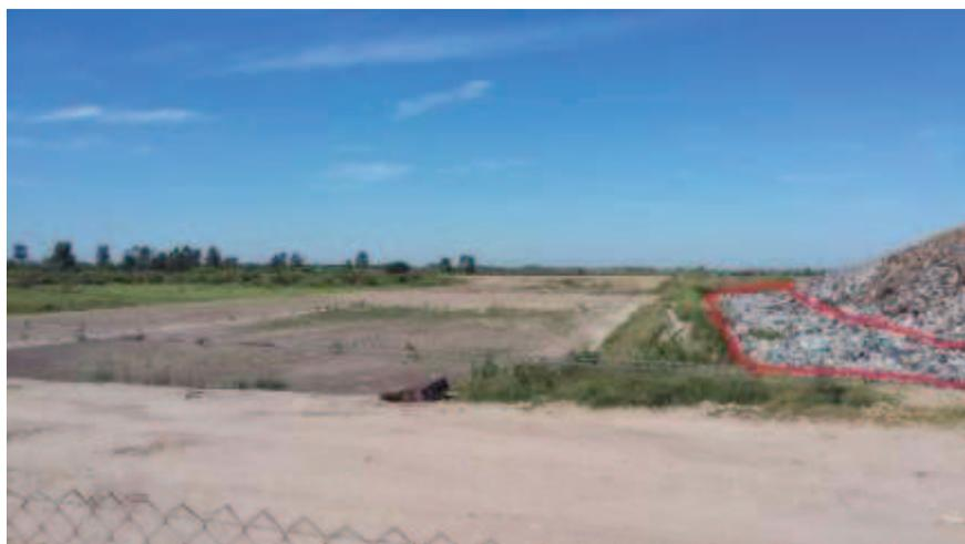
Fig. 1. Etapa de preparación del terreno (pozo izquierdo). Con la línea roja se representa un sector con basura sólida flotando en el lixiviado.
