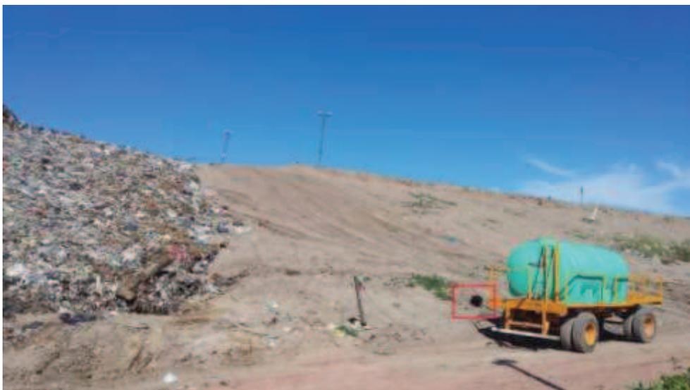
Fig. 3. Etapa de taponamiento. Se puede observar los tubos de recolección de lixiviado (cuadro rojo).
