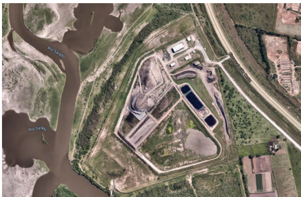
Figura 5.6: Predio del Complejo Ambiental de Santa Fe y Área Metropolitana. Fuente: Google Earth
