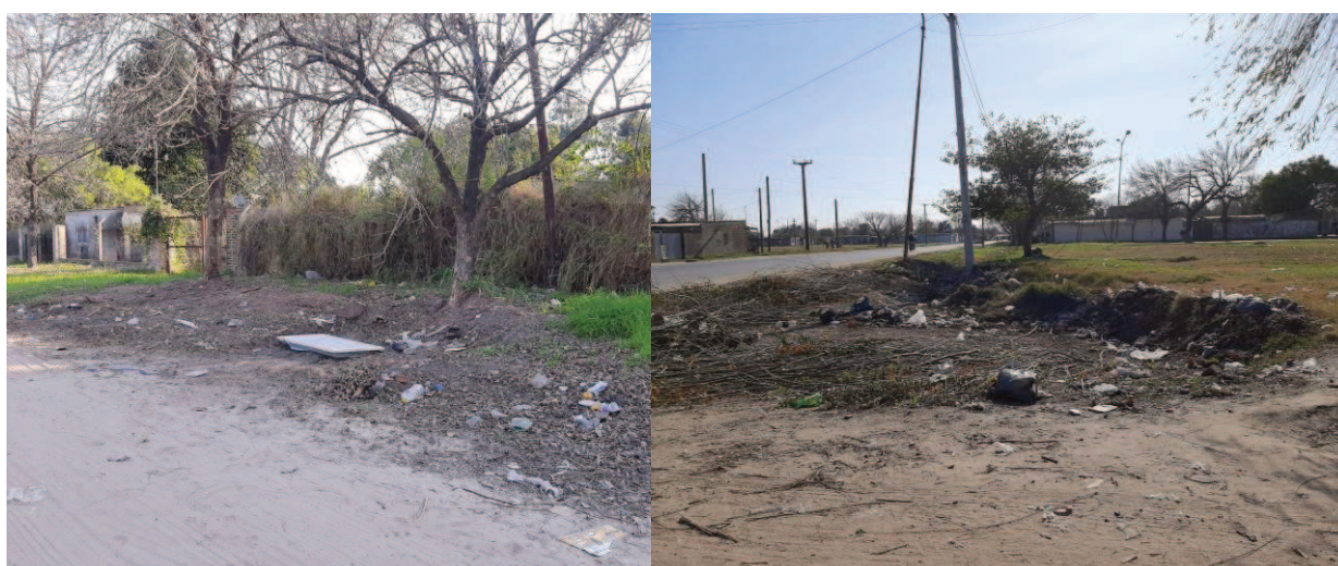
Figura 6.8: La recolección de ramas con retro pala genera rotura de veredas y afectación al arbolado de alineación. Fuente: Relevamiento Fotográfico 06 y 10/07/2021.
