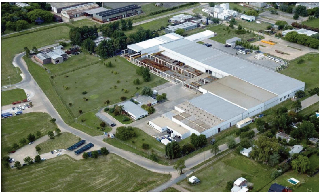
Figura 2.1 Vista aérea de CINTER S.R.L.
