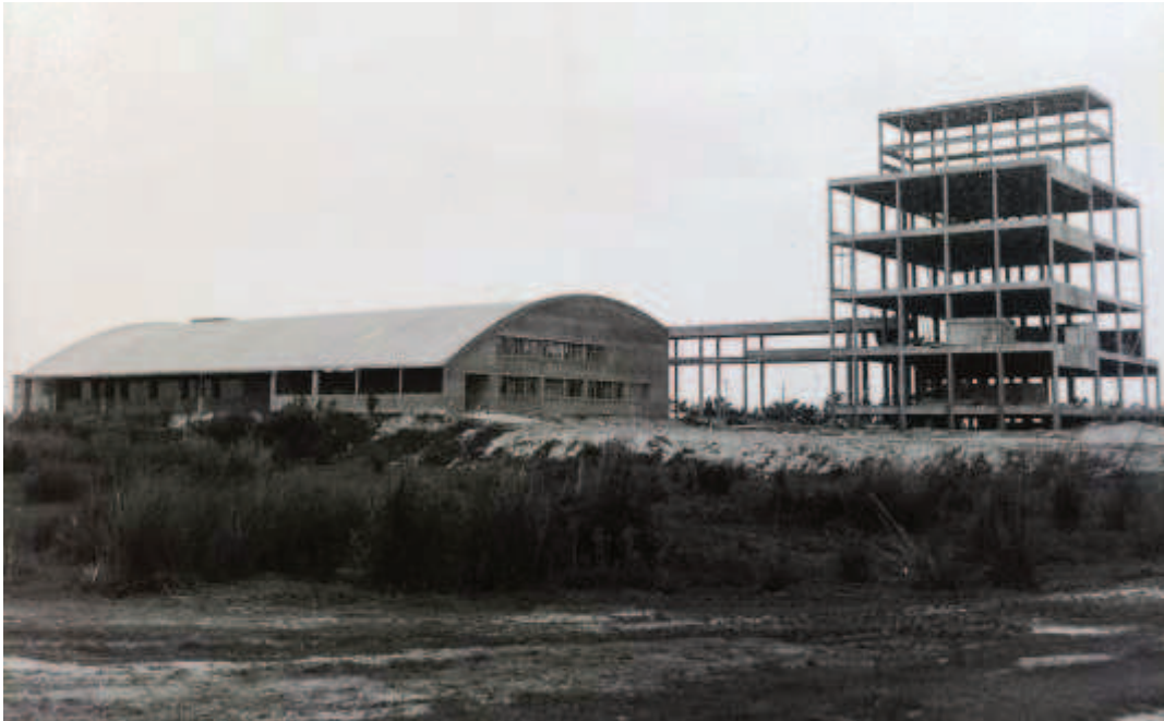
Fotografía de la puesta en obra, desde noroeste. Se aprecia el laboratorio avanzado y el bloque con la pasarela en la etapa de construcción de la estructura de hormigón armado, además se evidencia la diferencia de nivel del terreno refulado con el suelo natural, ca. 1979 / ADCU-UNL
