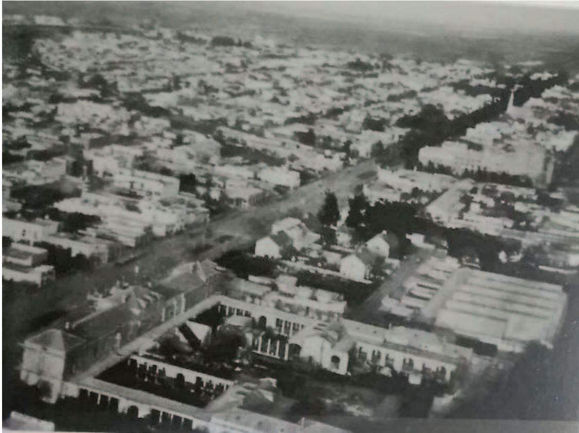
Construcción del edificio de Rectorado UNL Vista aérea (1933) / Archivo El Litoral, en: Collado, 2019:214
