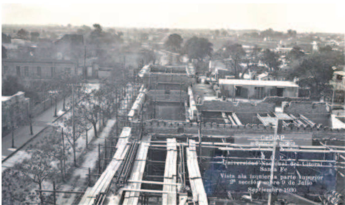
Vista general de las obras en construcción en la manzana del Rectorado y la FCJS. Imagen tomada desde la esquina del Bulevar Pellegrini y 9 de Julio mirando hacia el norte, observándose hacia el fondo la baja ocupación del entorno más allá de la calle Cándido Pujato, que presentaba grandes vacíos, septiembre de 1930 / CEDIAP, Foto MOP N.º 1396-02095
