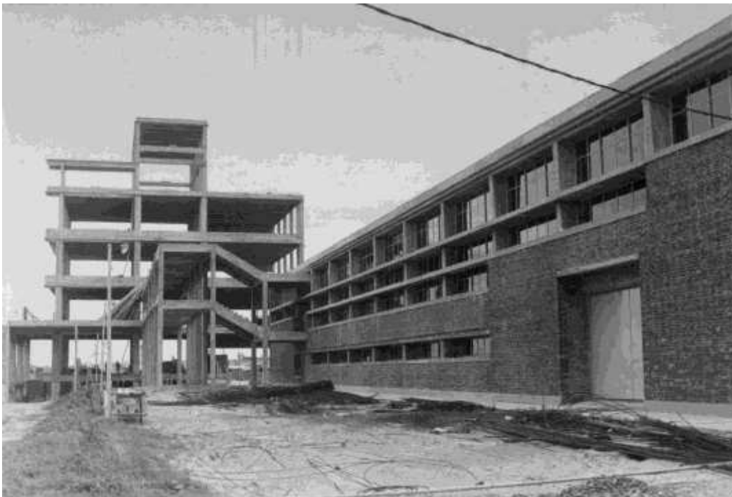
Fotografía de la puesta en obra, desde sureste. Se aprecia el laboratorio avanzado y el bloque con la pasarela en la etapa de construcción de la estructura de hormigón armado, ca. 1979 / ADCU-UNL
