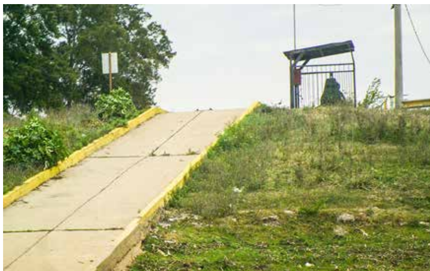
Imagen 8. Estaciones de bombeo en terraplén Garello Zona San José del Rincón
