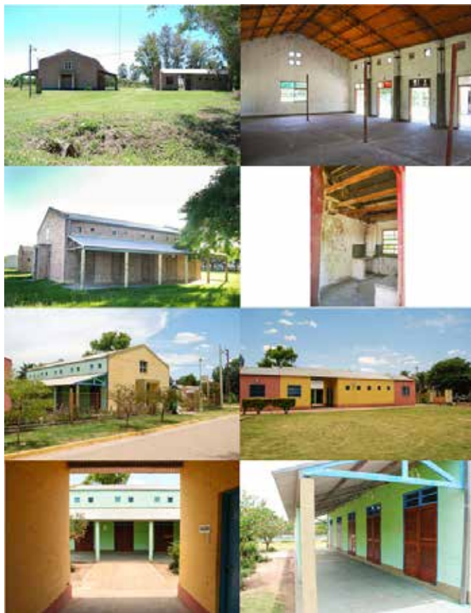
Imagen 9. Centros de evacuados para inundados construidos en el marco del Programa de Rehabilitación para la Emergencia de las Inundaciones. Departamento Garay
