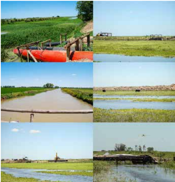
Imagen 4. Sistema de riego para el cultivo de arroz. Sistema de bombeo desde el río y canalización. Colonia Mascías
