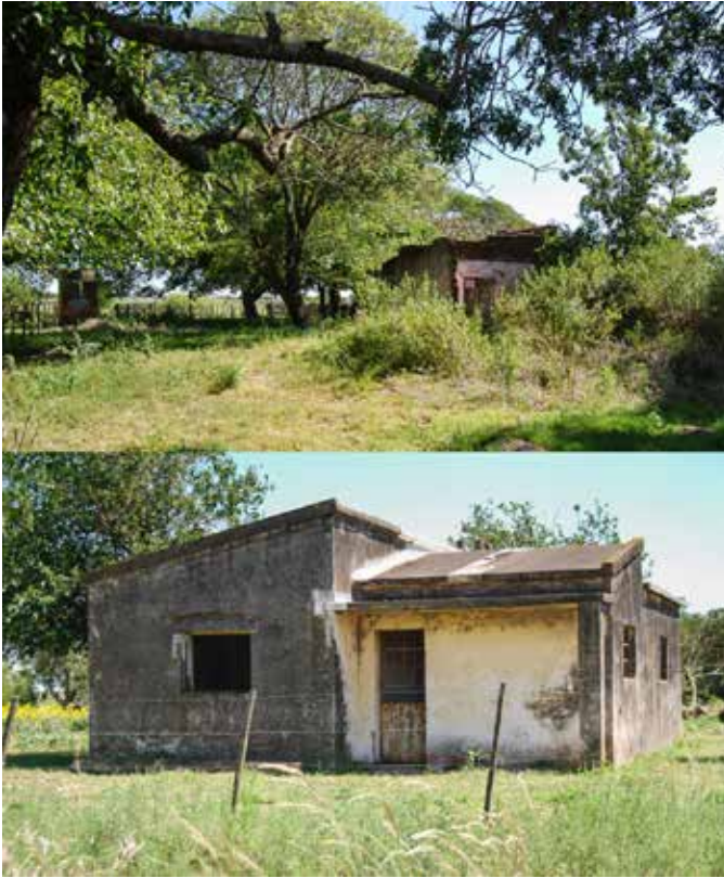
Imagen 1. Viviendas rurales abandonadas (taperas) en zona cercana a Cayastá
