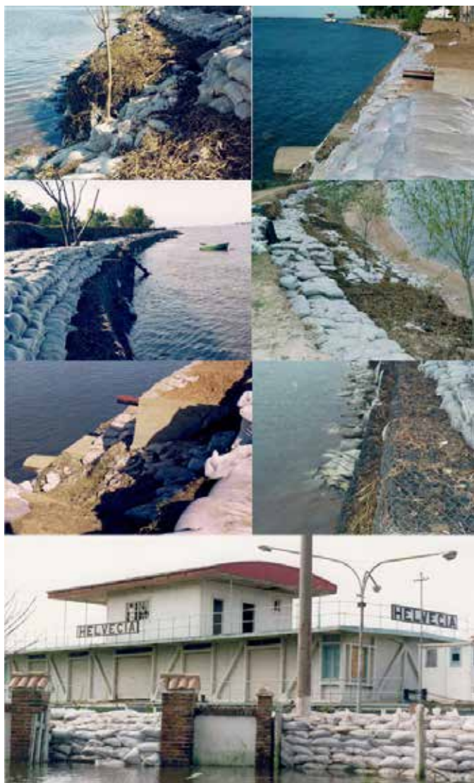
Imagen 11. Terraplenes de defensa inundación 1998, zona Helvecia. Gentileza del Senador Pignata
