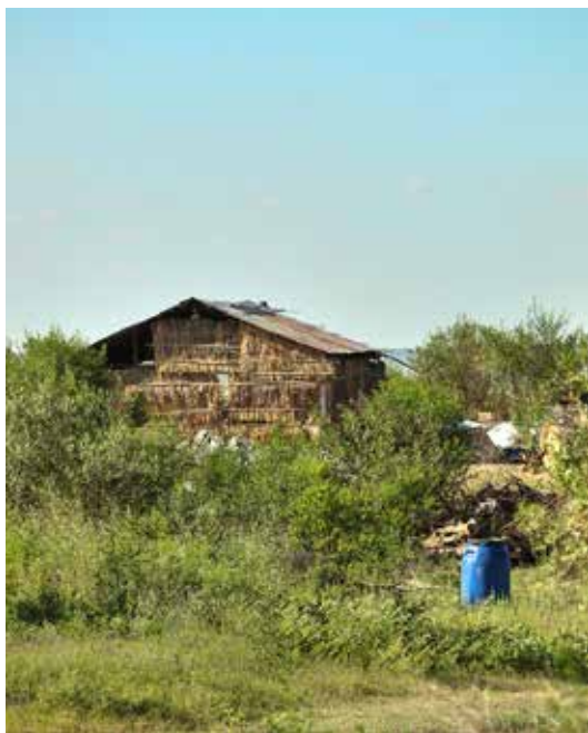
Imagen 3. Vivienda con techo y paredes de paja zona San José del Rincón
