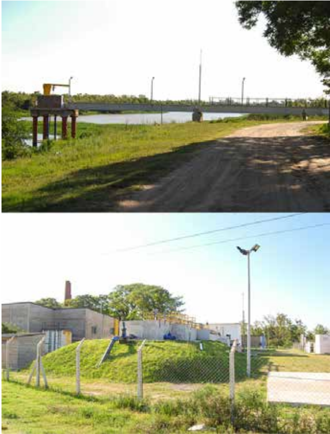
Imagen 19. Acueducto de la costa. Toma de agua
