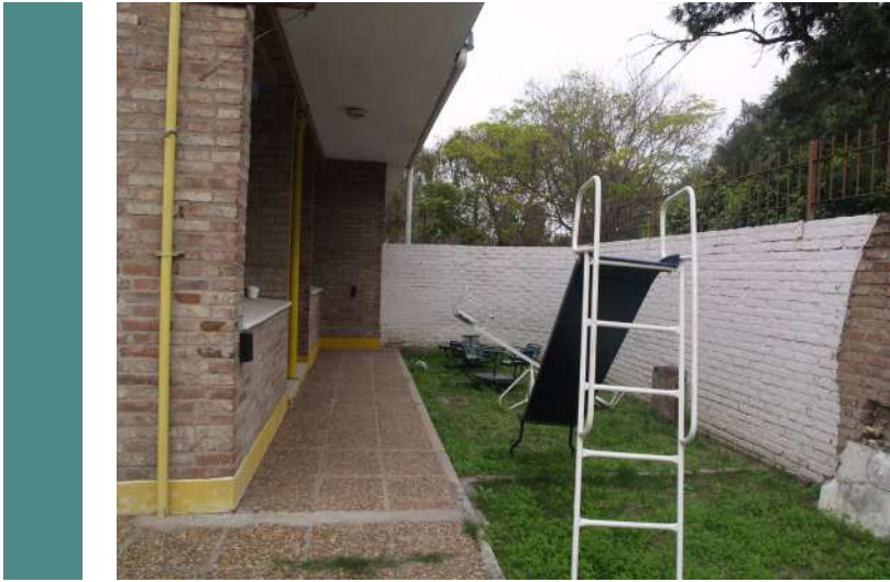
Foto 5 (Patio Anexo A Sala Nivel Inicial)
