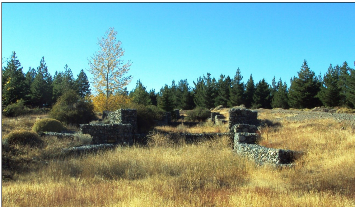
Figura 1.4: Imagen de las Obras del Canal Derivador
