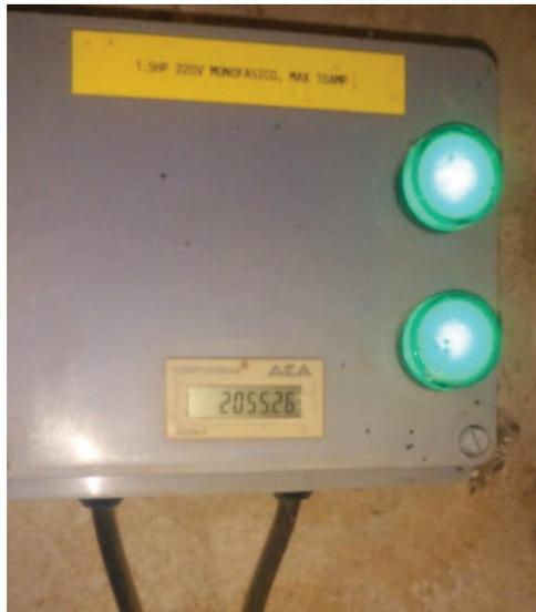
Figura III.11: Horómetro en funcionamiento en un tambo de los encuestados.
