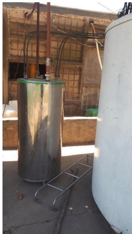
Figura III.3: Tanque recuperador de calor.
