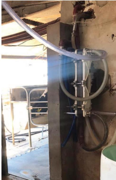
Figura III.2: Placa de refresco o intercambiador de calor.
