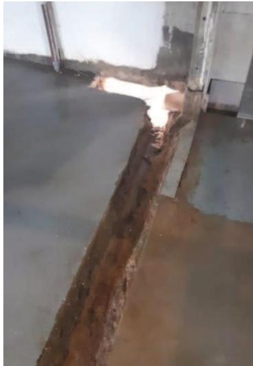
Figura I.66: Canal de desagüe y salida hacia el exterior- CASO A.
