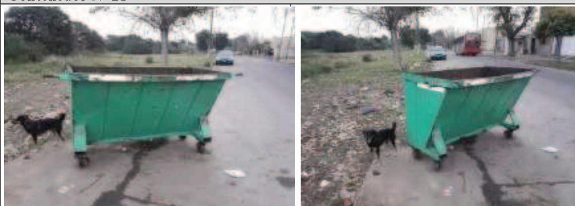
Figura 6.41: Se observa contenedor metálico ubicado sobre calle Luis Jimenez e intersección de calle peatonal Aldo Mieli. Poseen ruedas y una capacidad de 1000 litros. Servicio a manzanas 11 y 12. Fuente: registros propios del autor, 2024.
