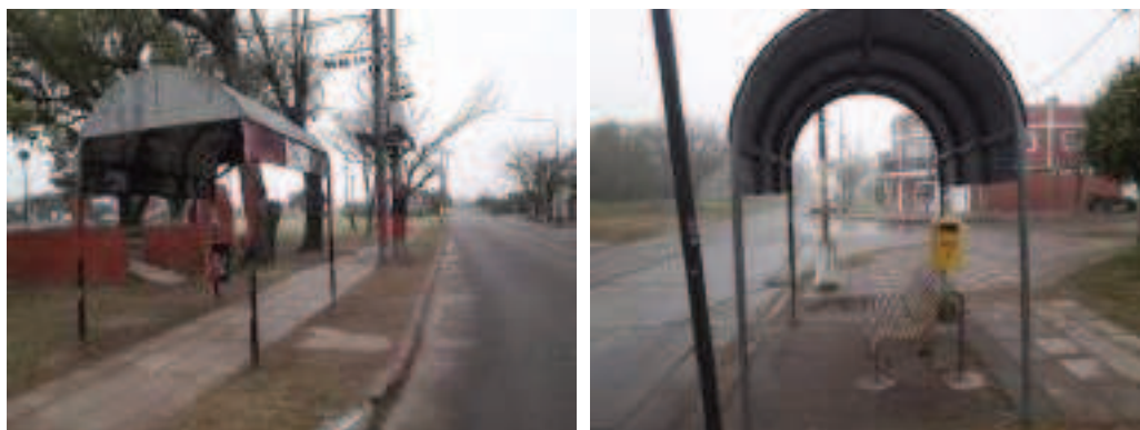
Figura 6.19: Vista de cestos garitas. Fuente Registros propios del autor, 2024
