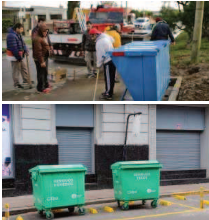
- Figura 8.3: Vista de dársenas para ubicación de contenedores. Fuente Diario El Litoral, 2018.
