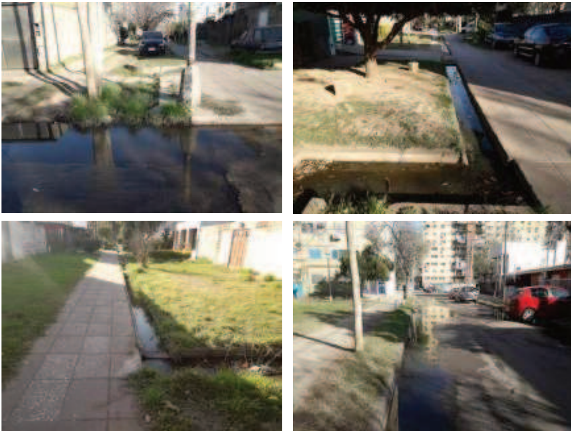
Figura 6.7: Vista de desbordes cloacales en calles. Fuente Registros propios del autor, 2024
