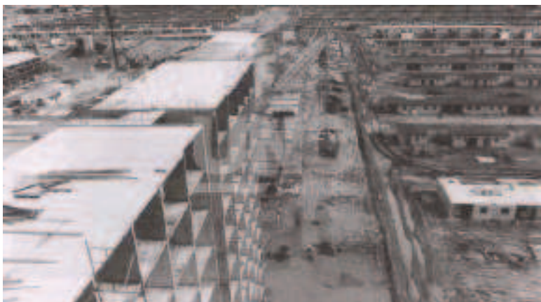
Figura 5.14: Construcción torres del barrio El Pozo. Fuente Diario El Litoral, 2014
