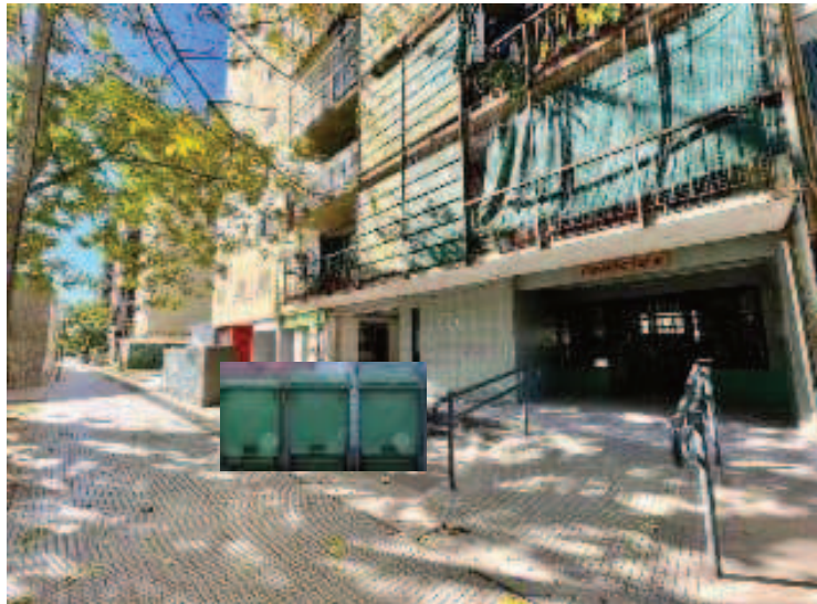
Figura 8.19: Vista de estación de transferencia en torres. Fuente Elaboración propia del autor, 2024
