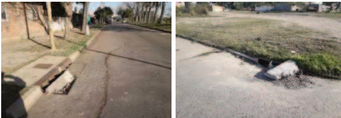
Figura 6.6: Vista de boca de tormenta. Fuente Registros propios del autor, 2024
