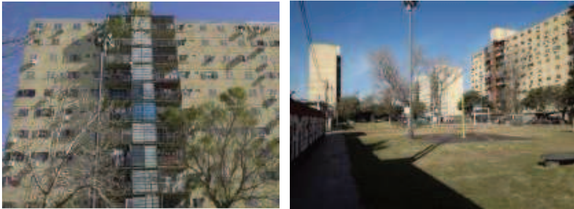
Figura 5.8: Vistas panorámicas de complejo de torres. Fuente Registros propios del practicante. 2024
