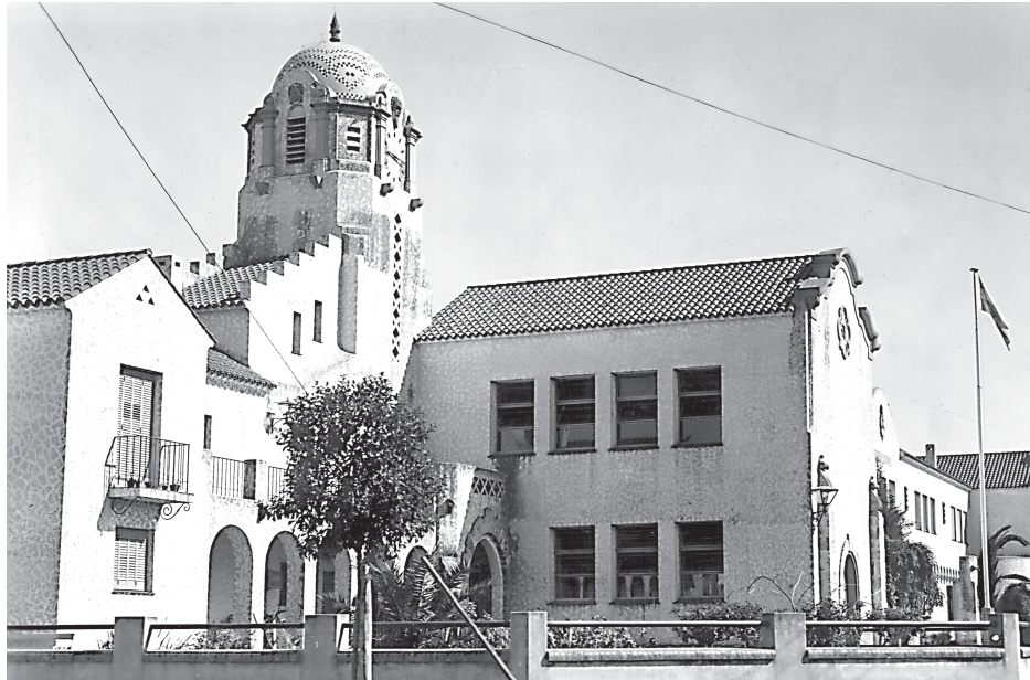
La Escuela Normal de la Nación apela al neocolonial como expresión arquitectónica, a diferencia de las escuelas provinciales que para la misma época se realizan en clave moderna. Foto de González Acha.
