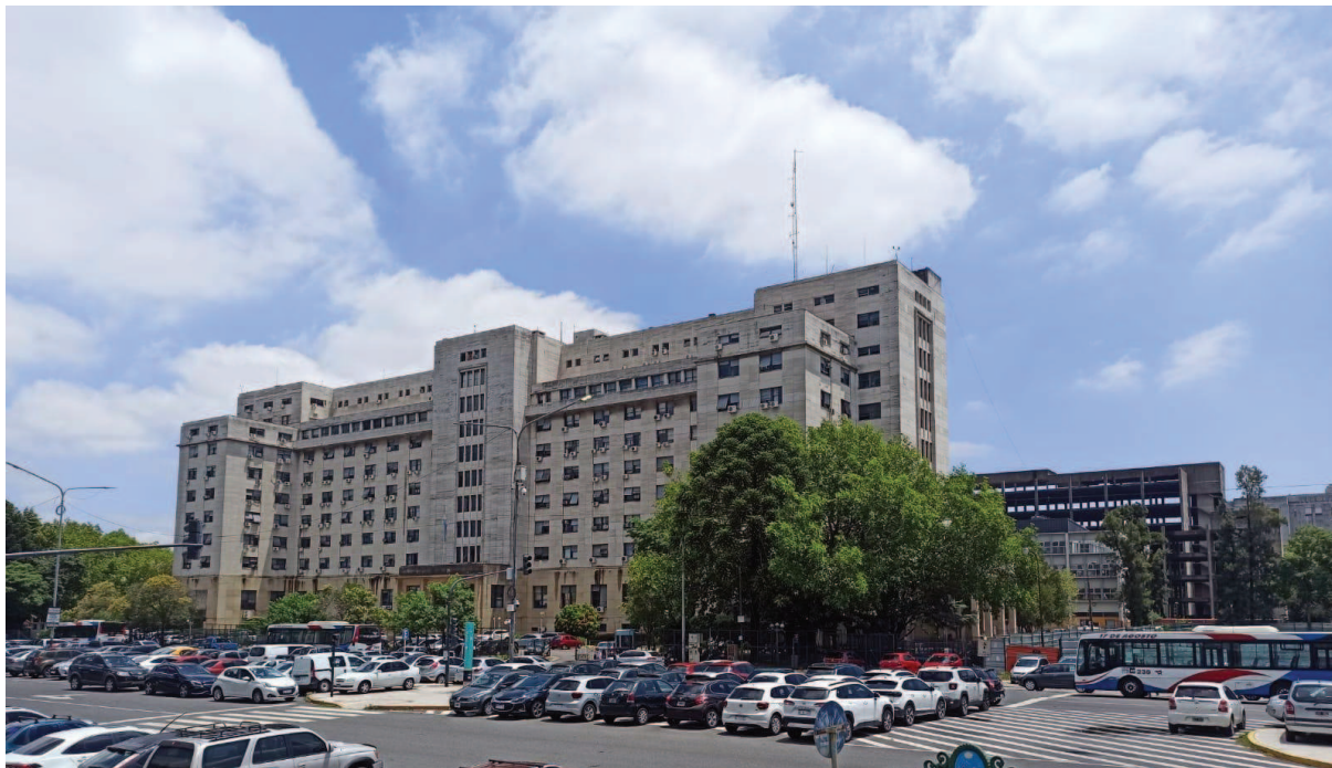
Fachada del edificio de Comodoro Py . Se aprecia detrás la estructura de hormigón armado de lo que hace varias décadas iba a ser el Hospital Aeronáutico y parte de la fachada del edificio de Inmigrantes , donde funcionan dependencias del fuero Civil y Penal Económico.
