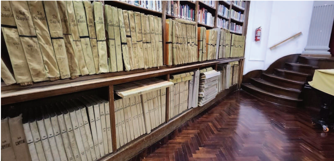
Imagen 1. Vista General de los ejemplares del Diario de La Capital , de la Hemeroteca del Consejo de Mujeres de Rosario, en la que se observa el deterioro avanzado de las encuadernaciones, la falta de protección física individual y el apilamiento inadecuado. Fuente: Elaboración propia (2025).
