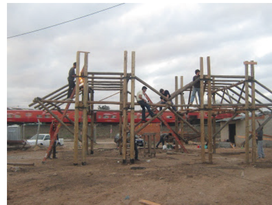
IMÁGENES DEL PROCESO CONSTRUCTIVO
