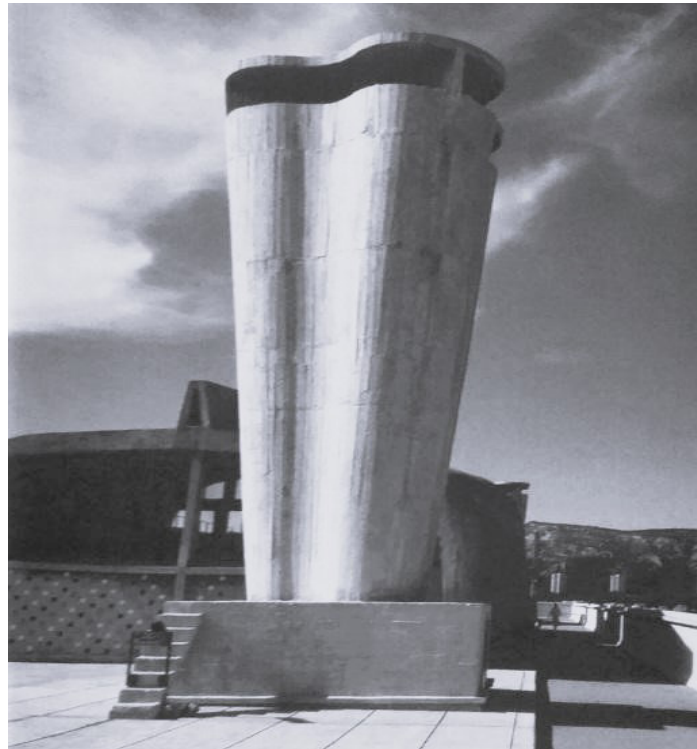
Figura 1.Int. Chimenea de ventilación de la Unité de Marsella. Le Corbusier 1952. Fuente: Martín-Gómez (2017).
