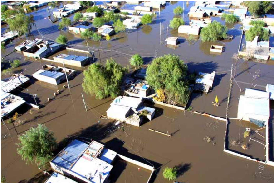
FOTO 2 – Vista de la inundación de la ciudad de Santa Fe-Barrio Barranquitas
