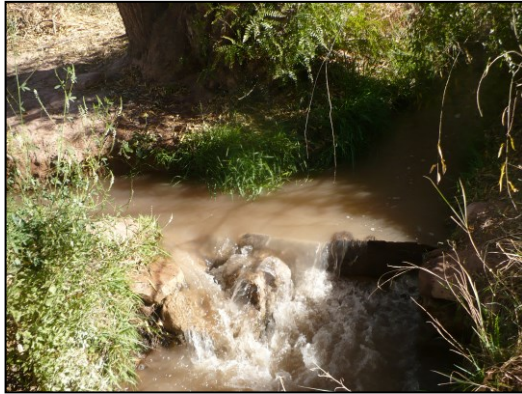
Compuerta precaria de chapa para derivación de caudal a parcela
