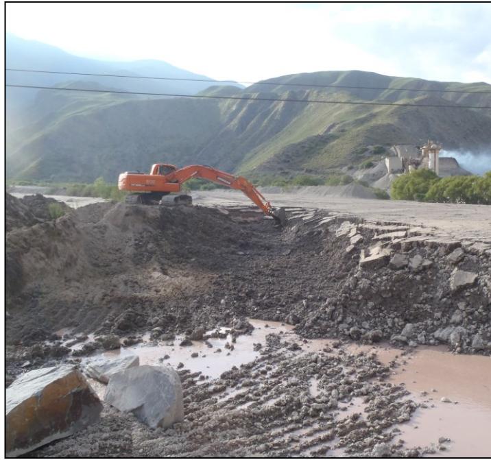
Figura 6.4: Maquinaria pesada realizando tareas de remoción de material depositados por flujos densos en la localidad de Volcán. Fecha: 19-diciembre-2012. Al fondo se ve la planta industrial productora de cal de esta localidad. Fuente: Juan Pablo Zamora Gómez.
