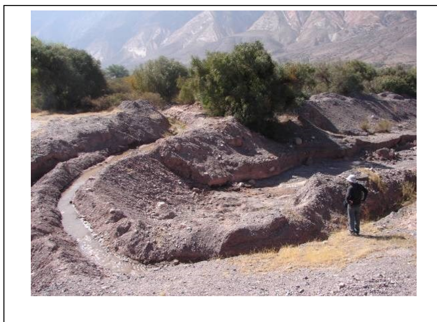
Figura 10.2: Cruce precario del canal CS2A por A° Quebrada Bordo La Pera. Actualmente en este sitio se está emplazando un puente-canal.
