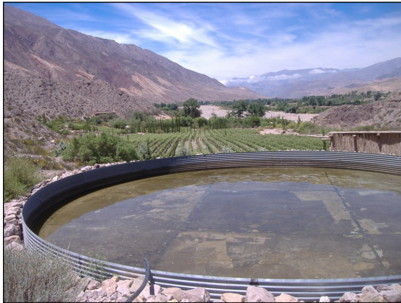
Figura 2.18: Tanque australiano abastecido por una perforación en Finca Dupont. Al fondo se observan los viñedos. Foto: J. P. Zamora G.
