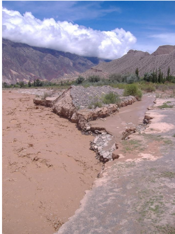
Figura 6.3: Afectación de la toma 1 por la crecida del río Grande (febrero-2011). Foto: J. P. Zamora G.
