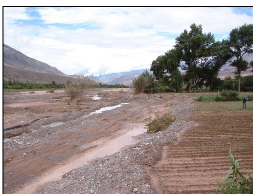
Afectación de campos de cultivo por acción erosiva del río.
