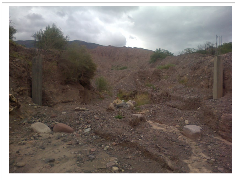
Figura 10.3: Columnas de puente canal instaladas en arroyo Bordo La Pera. Fecha: 05 de febrero de 2015. Foto: J. P. Zamora G.
