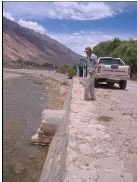
Defensa de hormigón armado y piedra revestida, en camino de costanera de margen derecha del río Grande.
