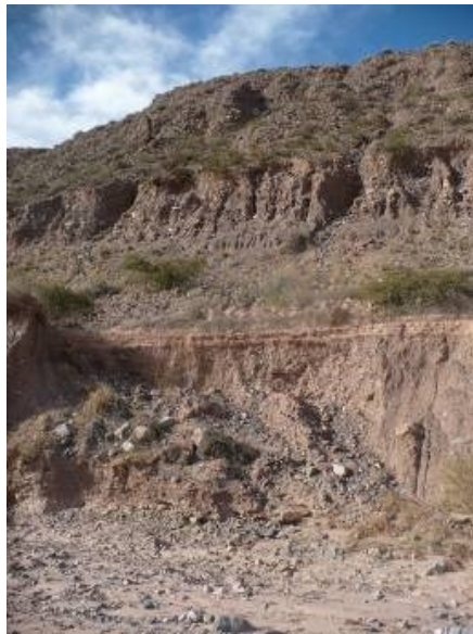
Figura 6.1: Canal Pie de la Cuesta, colapsado por acción del río Grande. Margen izquierda del distrito de riego de Maimará. Foto: J. P. Zamora G.
