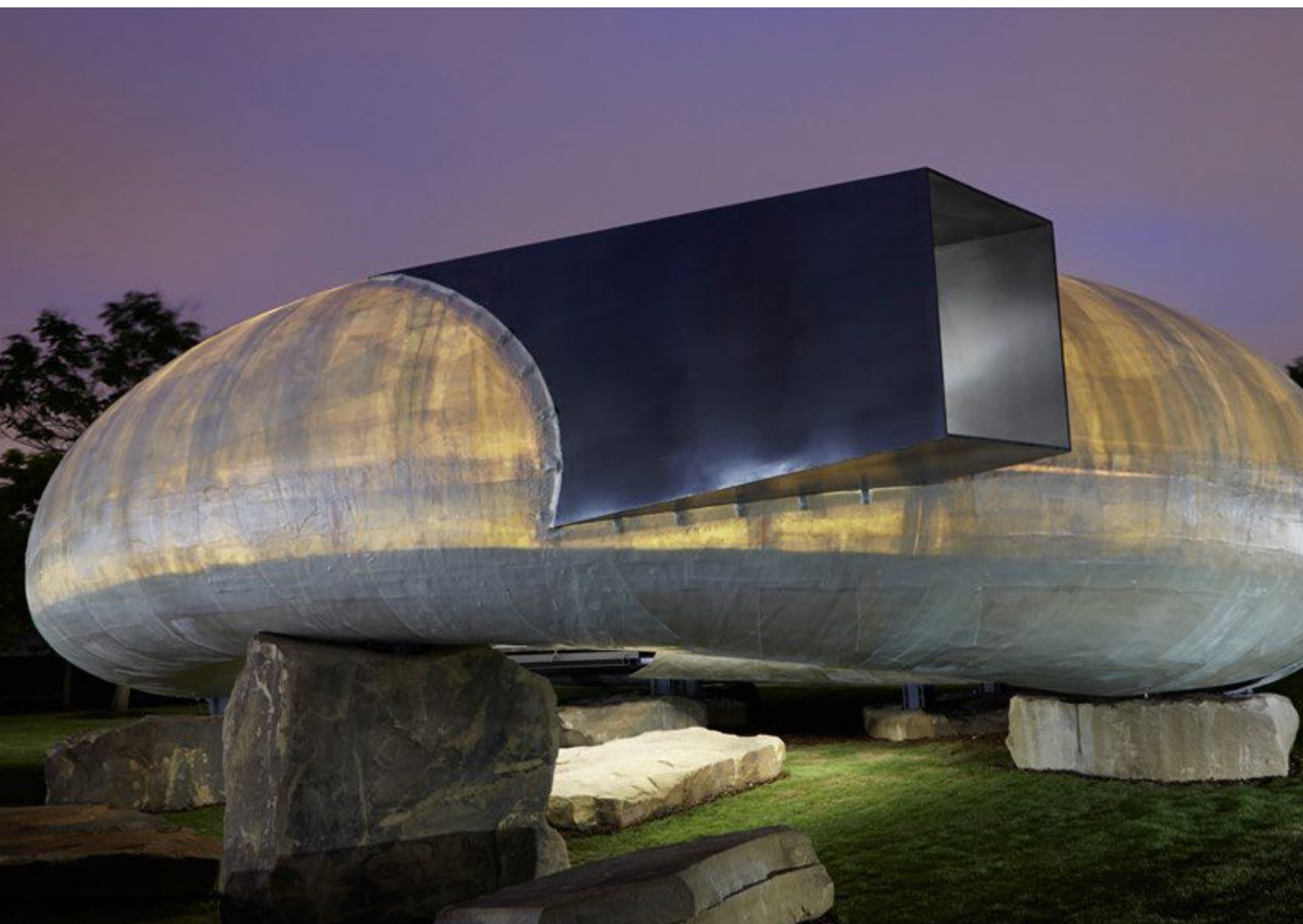
27. Pabellón temporario, Serpentine Gallery de Londres, Smiljan Radic, Londres, 2014.
