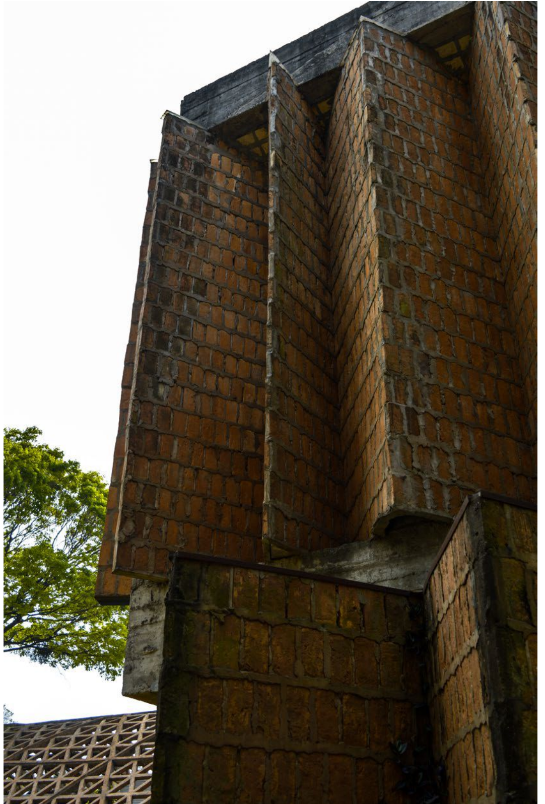
19. Fundación Teletón, Solano Benítez, Paraguay, 2010. Ejecución de obra.
