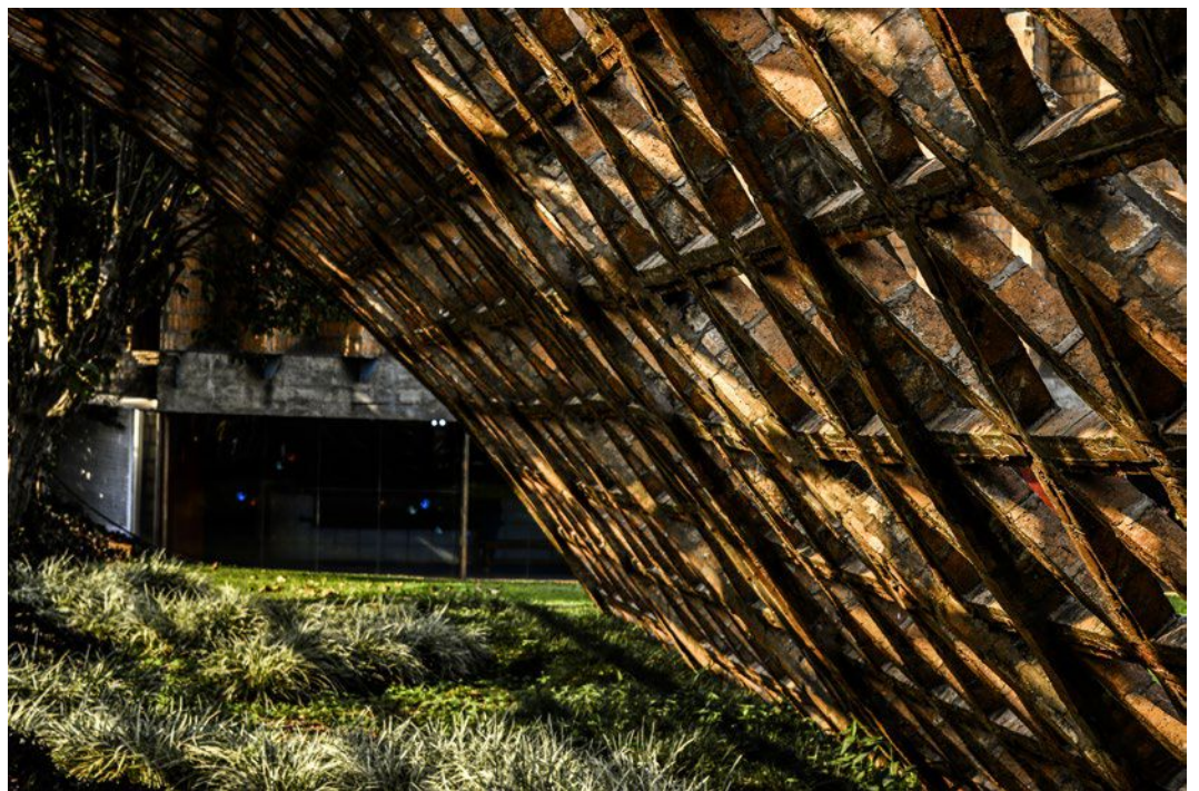
18. Fundación Teletón, Solano Benítez, Paraguay, 2010. Ejecución de obra.
