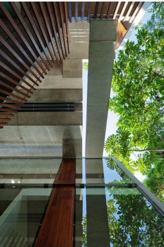
29.1 Casa en Ubatuba, Angelo Bucci (SPBR Arquitectos), Brasil, 2005. Ejecución de obra.
