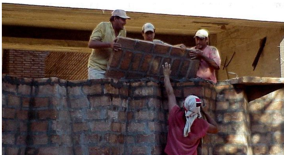
14.4 Casa Esmeraldina, Solano Benítez y Gabinete de Arquitectura, Paraguay, 2000.
