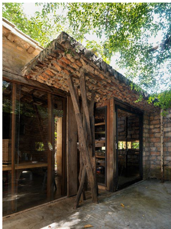
14.2 Gabinete de Arquitectura, Solano Benítez, Paraguay.
