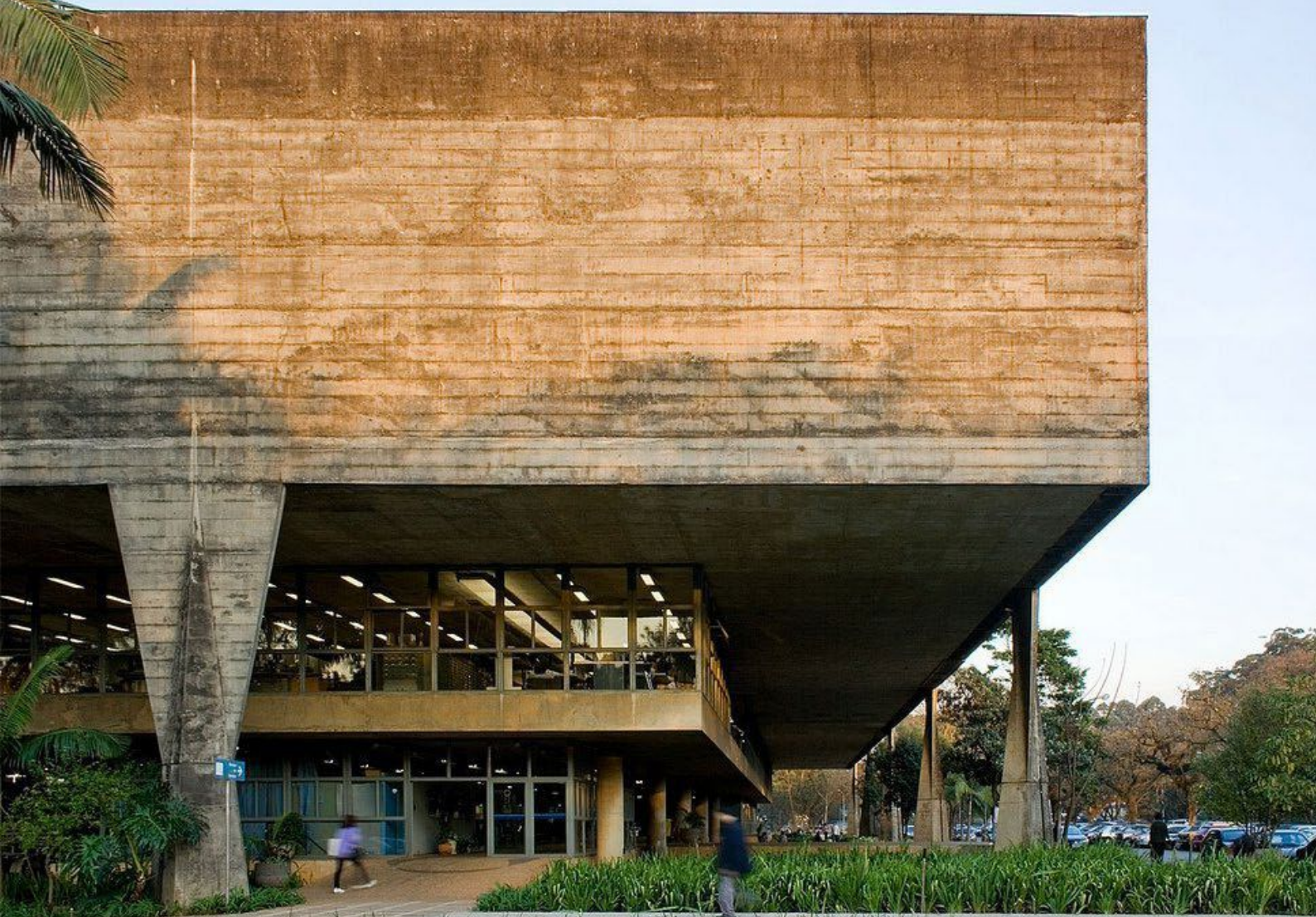
1-2 Facultad de Arquitectura y Urbanismo, Universidad de San Pablo, João Batista Vilanova Artigas y Carlos Cascaldi, San Pablo, Brasil, 1961.
