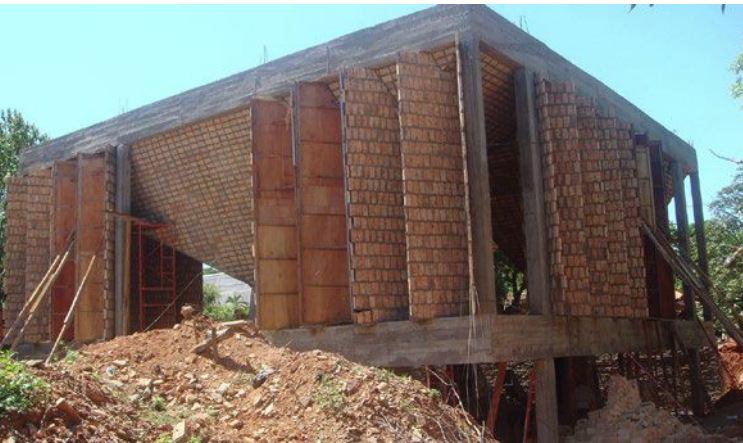
8. Fundación Teletón, Solano Benítez, Paraguay, 2010. Ejecución de obra.
