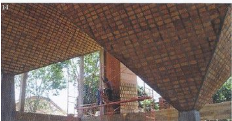
10. Fundación Teletón, Solano Benítez, Paraguay, 2010. Ejecución de obra.
