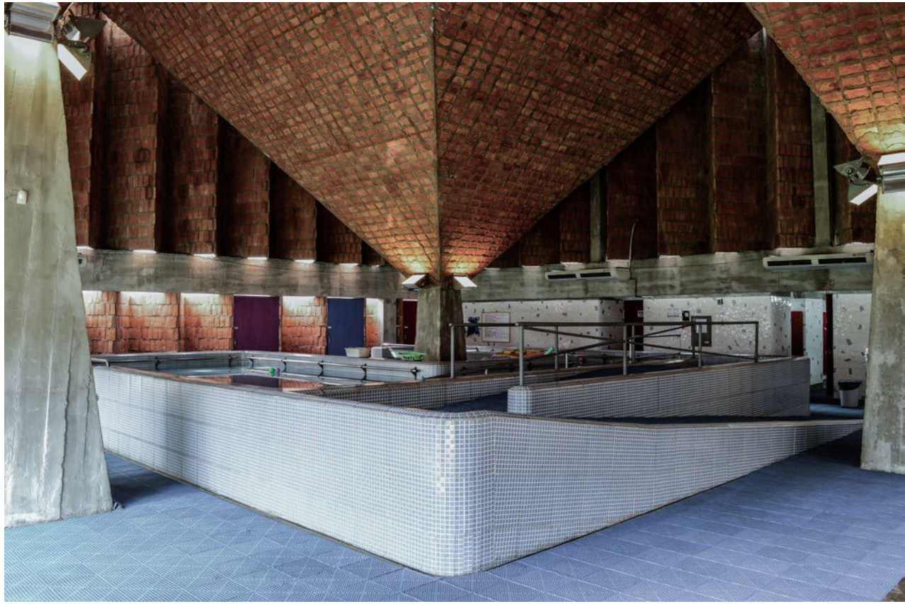
20. Fundación Teletón, Solano Benítez, Paraguay, 2010. Ejecución de obra.
