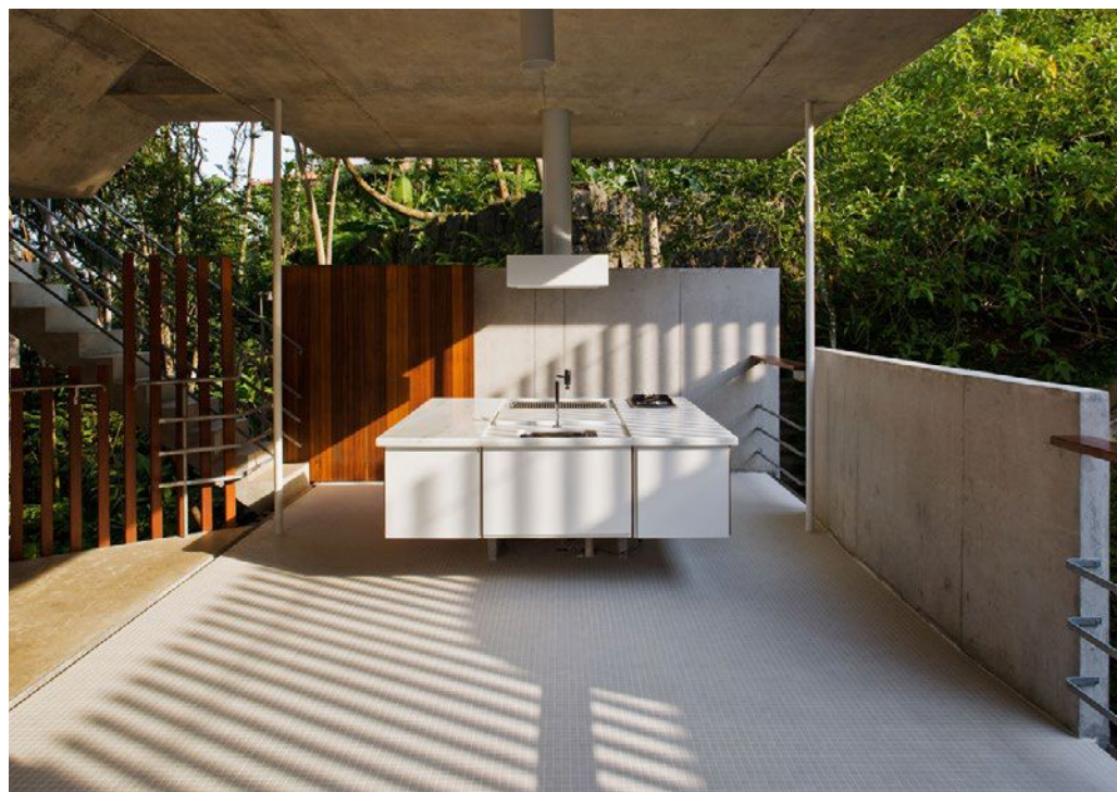
29.2 Casa en Ubatuba, Angelo Bucci (SPBR Arquitectos), Brasil, 2005. Ejecución de obra.
