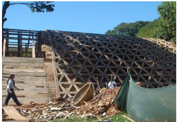
9. Fundación Teletón, Solano Benítez, Paraguay, 2010. Ejecución de obra.
