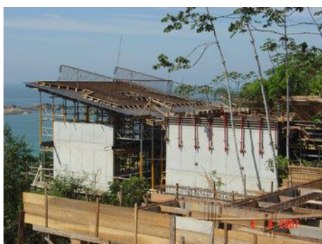
29. Casa en Ubatuba, Angelo Bucci (SPBR Arquitectos), Brasil, 2005. Ejecución de obra.
