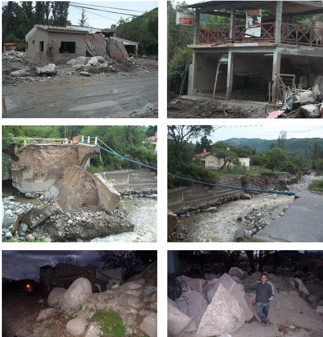
Figura 1. 30: Daños ocasionados en la localidad turística de El Rodeo por la crecida del Río Ambato
