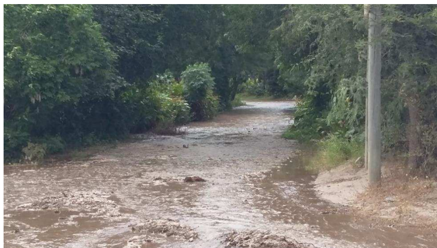
Figura 1. 44: Escurrimiento superficial del río Paclín por camino vecinal (cauce activo del río antes de la construcción del terraplén)
