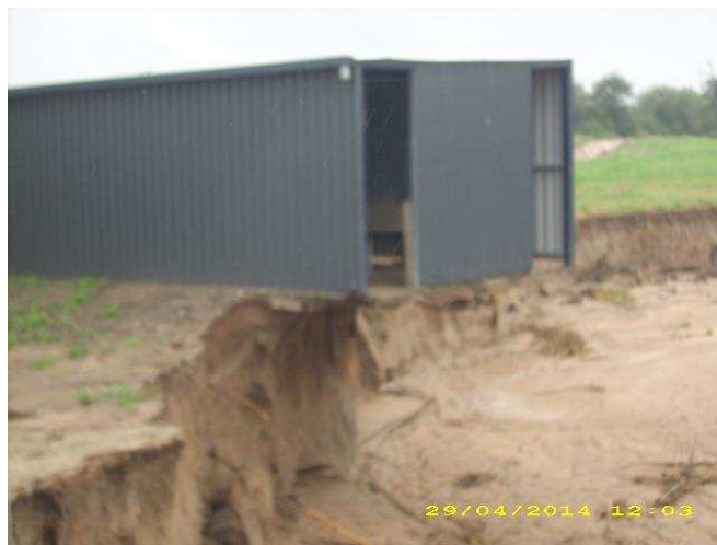
Figura 1. 36: Cárcava generada por los desbordes del río Ovanta en La Bajada (afectación estancia La Tirolesa). Abril 2014
