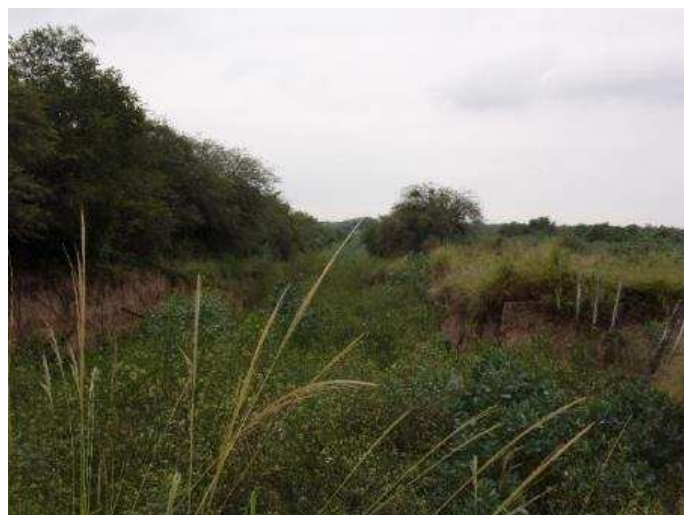
Figura 1. 39: Cárcava conformada en un camino rural (sector norte de Puerta Grande) de 500 m de longitud y 10 m de profundidad.
