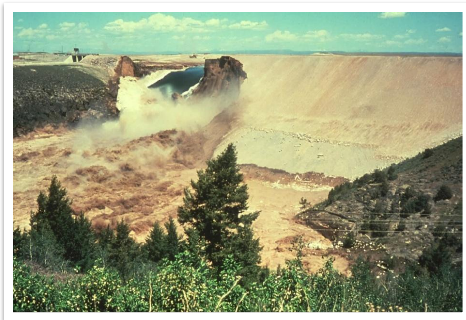
Ilustración 4-7: Colapso de la Presa Teton, Junio 5 de 1976. Tomado de USCE.
