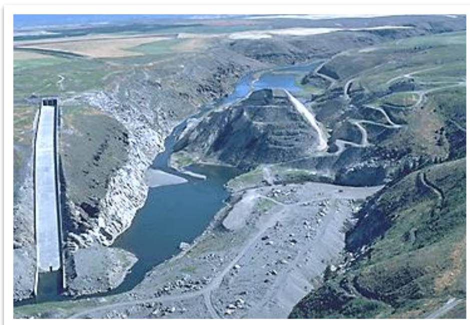
Ilustración 4-8: Presa Teton luego del colapso. Tomado de USCE.
