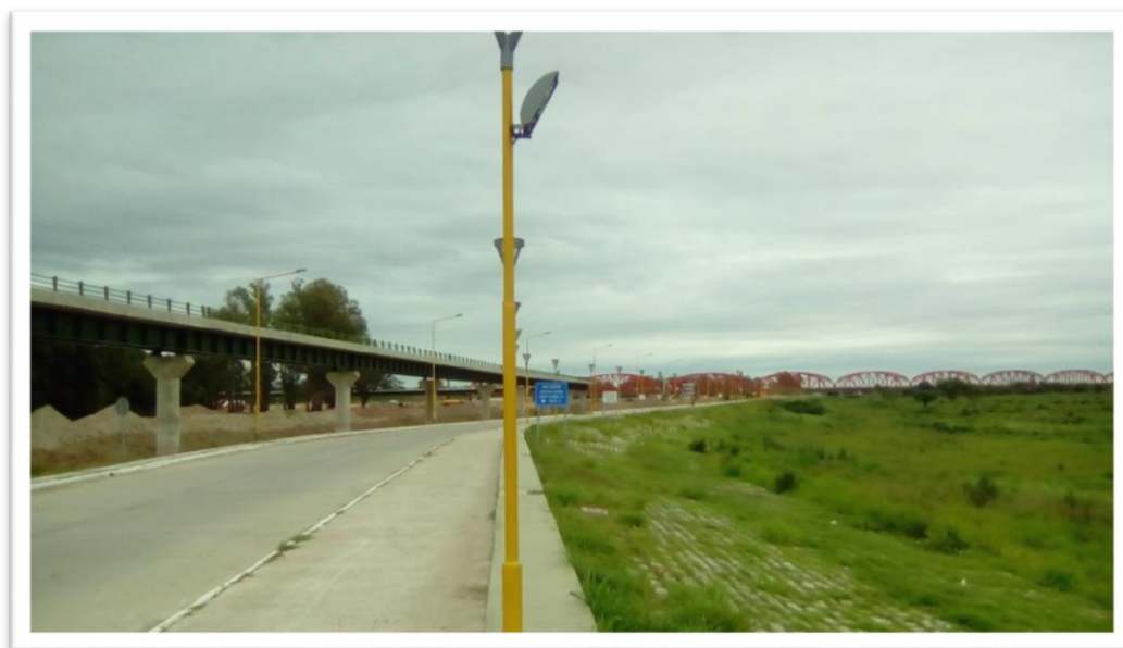
Fotografía 13: Vista de la infraestructura urbana a la altura del sitio 6. Arriba corre la vía del tren hacia el Puente Negro, abajo se puede observar la avenida de costanera. Fotografías: Marta Leiva.
