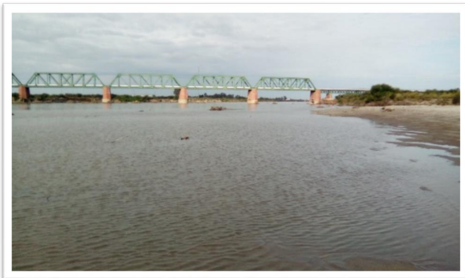
Fotografía 11: Vista del sitio 6 desde el interior del cauce, entre el puente ferroviario conocido como Puente Negro (en la foto) y el Puente Carretero aguas arriba. Fotografías: Marta Leiva.
