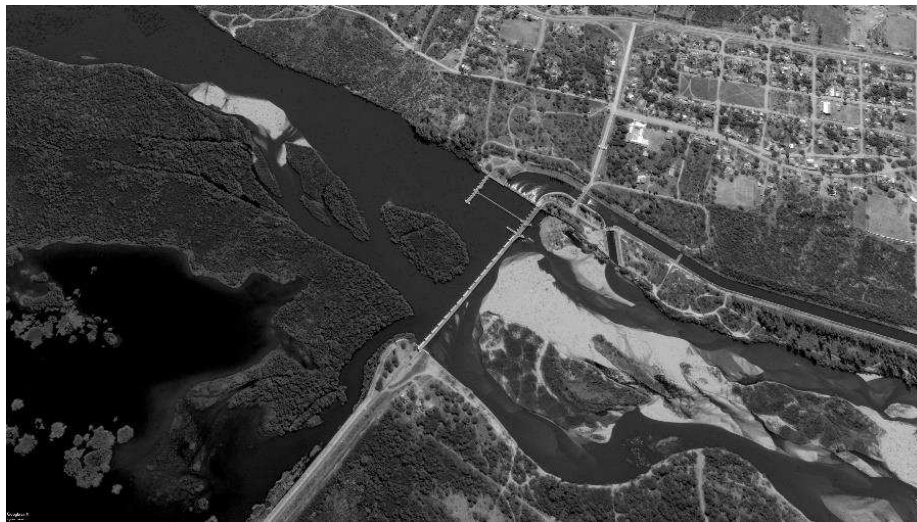
Figura IV.2: Detalle del Río Dulce donde se localiza la presa de derivación (centro) y Canal Matriz del sistema de riego (centro arriba). Se puede observar el área del lecho desecada por la disminución del caudal aguas abajo de la presa. Fotografía: Google Earth , fecha de la imagen Julio 2015.
