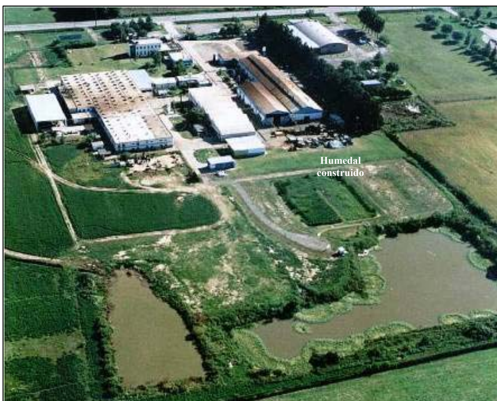
Fig. VII.2. Foto aérea del humedal construido en la planta metalúrgica SNA-E.
