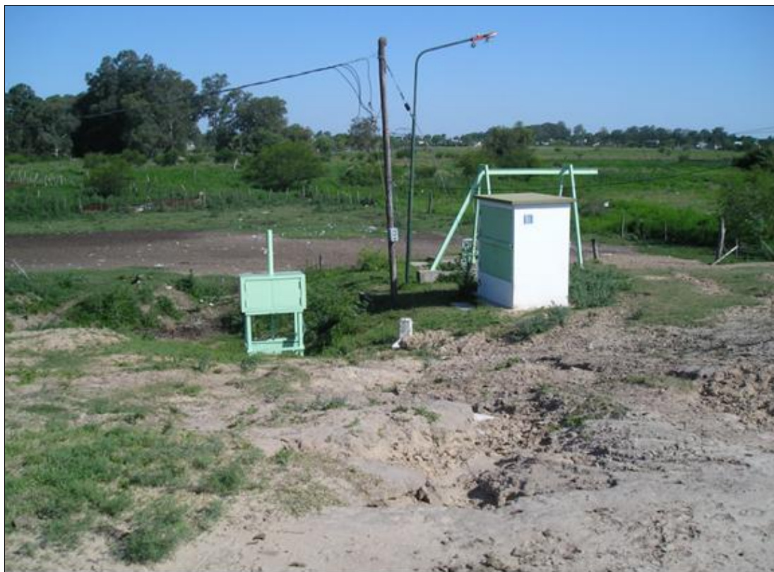
Fig. 26 - Terraplén sin mantenimiento y estación bombeo a reparar en Colastiné Norte; al fondo las áreas defendidas. (Foto: Vivas J., Sep. 2007).
