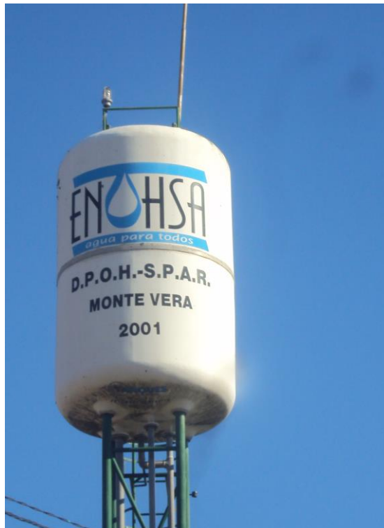
Figura 29: Tanque de provisión de agua
