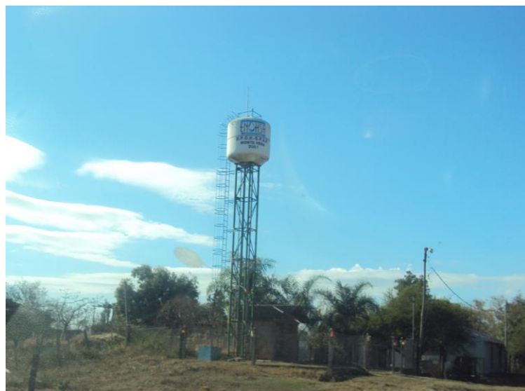
Figura 24: Tanque de provisión de agua
