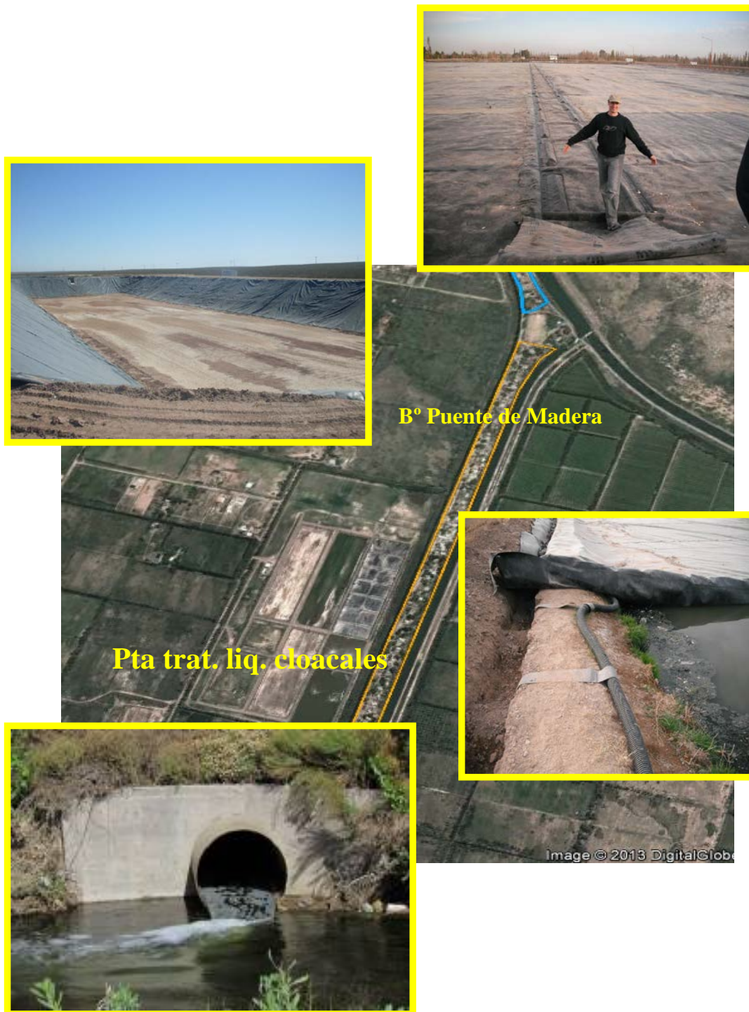
Figura 7.2: Planta depuradora de líquidos cloacales
