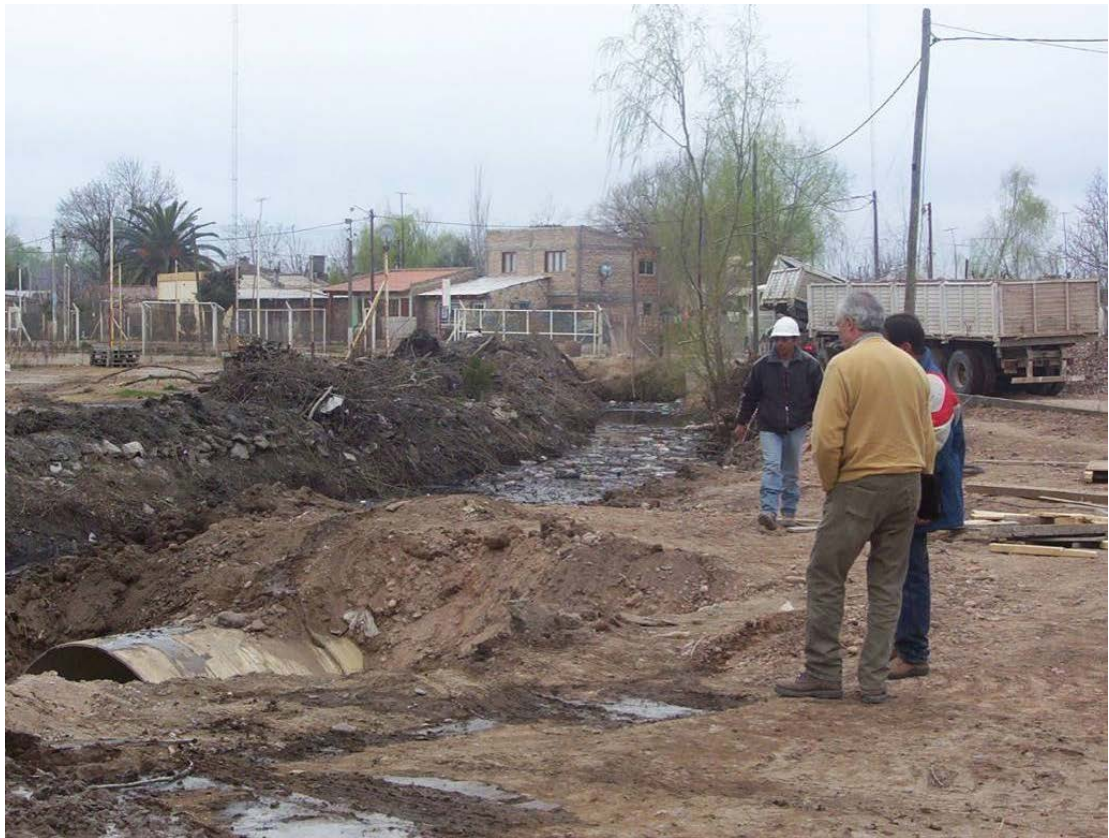
Figura 7.5: Entubado del Canal de los Milicos en Barrio Labraña
