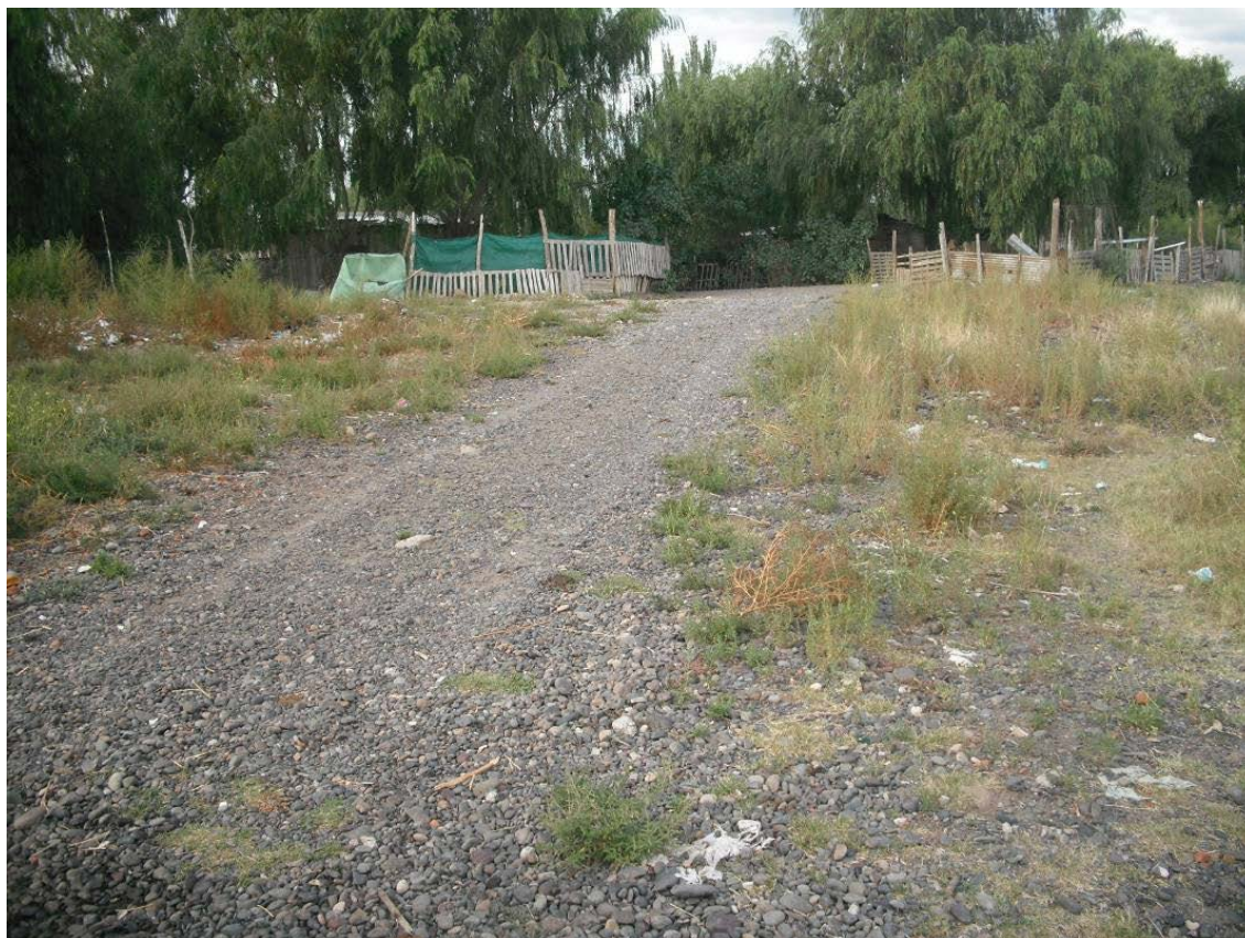
Figura 7.7: Protección contra inundaciones en B° Costa Norte
