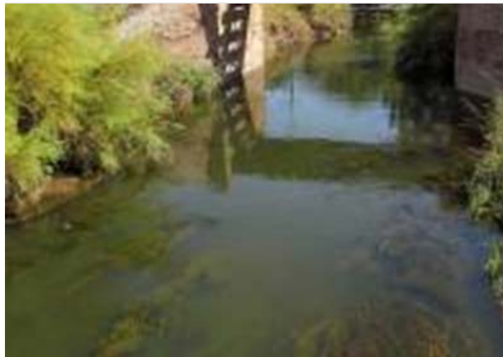
Sitio 7: Descarga E3 – Puente 83 en Ruta Provincial Nº 65
