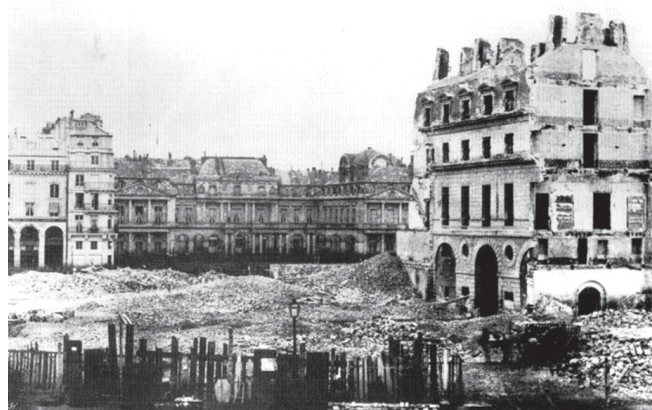
Figura N° 3. Demoliciones en París durante la reforma de Haussmann.
