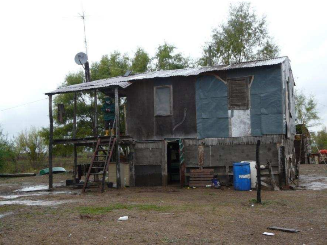
Viviendas de madera y chapa habituales en comunidades de pescadores de islas del delta (arriba, Foto: Claudio Baigún; abajo, delta medio Isla El Espinillo 25-04-2017).
