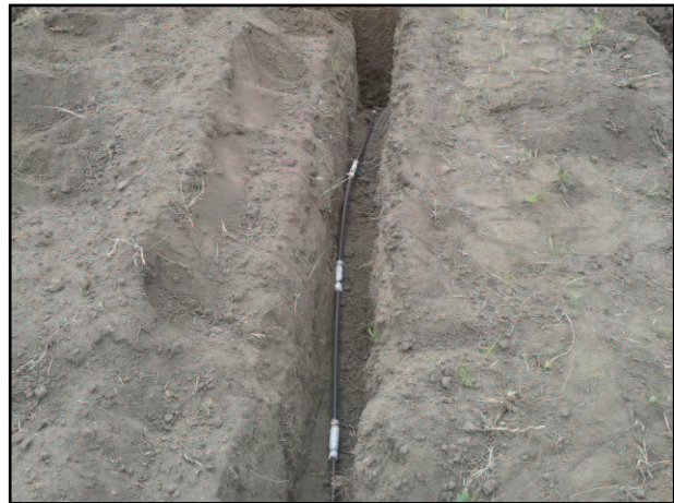
Colocación de la tubería integrada de goteo subterráneo
