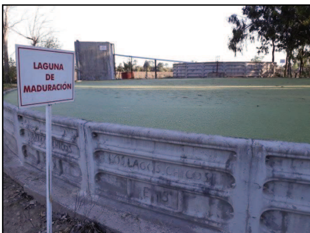
Laguna de Maduración
