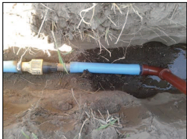
Regulador de presión del equipo de goteo
