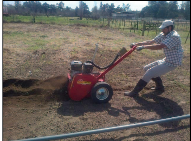
Inicio de los trabajos de instalación del riego subterráneo
