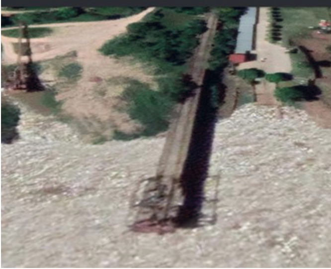
Figura 16.4.8. Obras de toma en Paraná: muelles 1 y 2.
