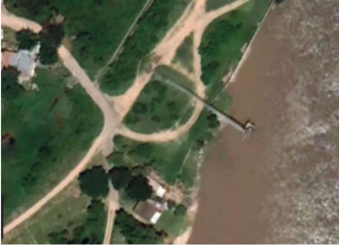
Figura 16.4.9. Obra de toma en Santa Fe. Río Colastiné
