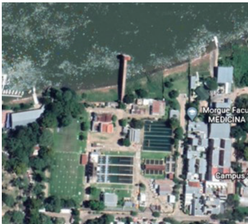
Figura 16.4.5. Obra de toma en Corrientes
