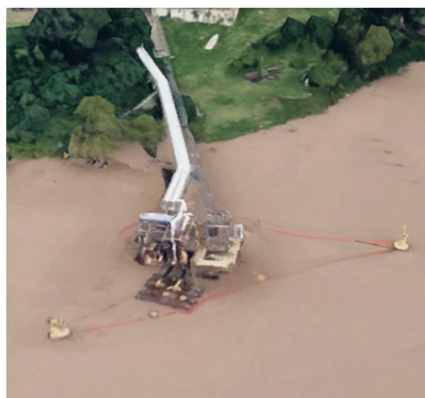
Figura 16.4.12. Obra de toma-planta potabilizadora Rosario
