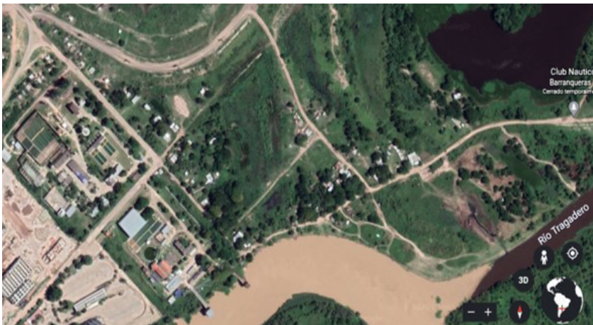
Figura 16.4.6. Obras de toma en Barranqueras
