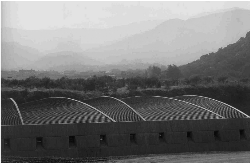
Planta de tratamiento de aguas servidas, Santiago, Chile. Peñafiel, López, Noél.
