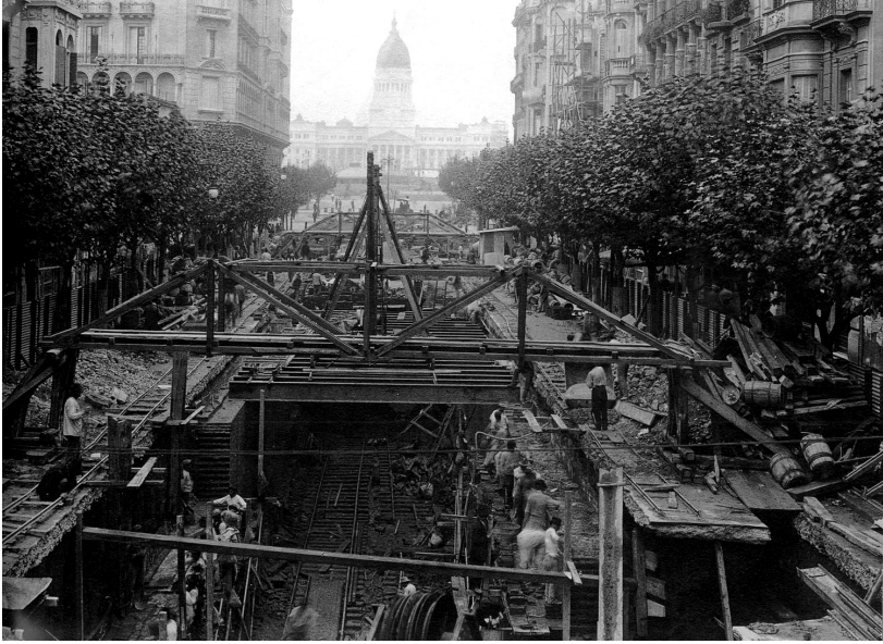
Subterráneo Línea A en construcción. Buenos Aires.
