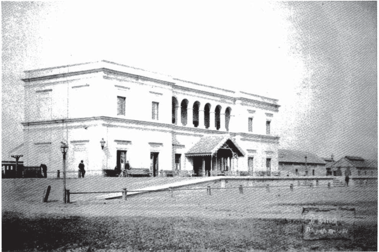
Estación de Santa Fe terminada (fachada a la calle)
