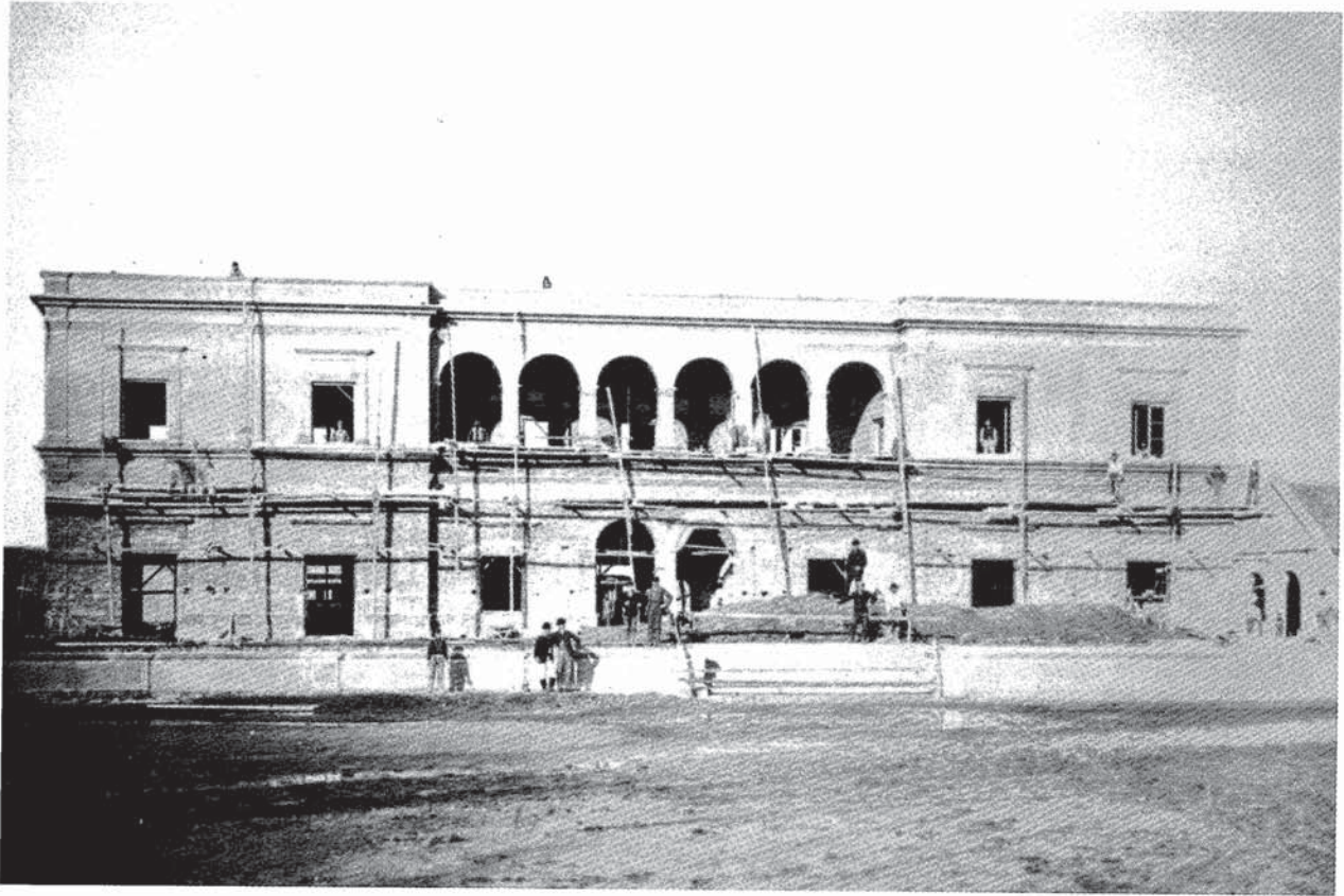
Estación de Santa Fe en construcción (fachada a la calle)
