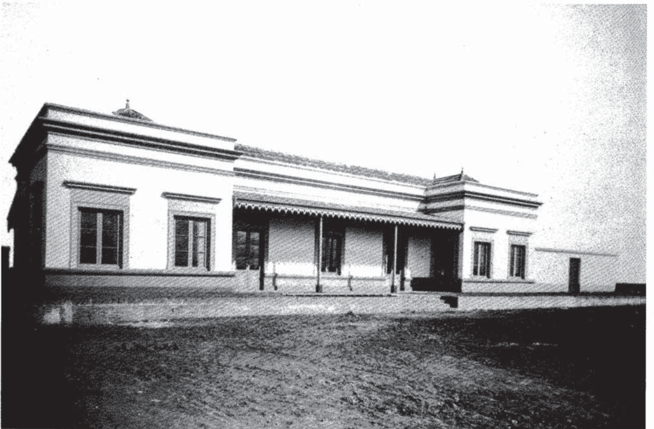
Estación Esperanza (vista a la calle)
