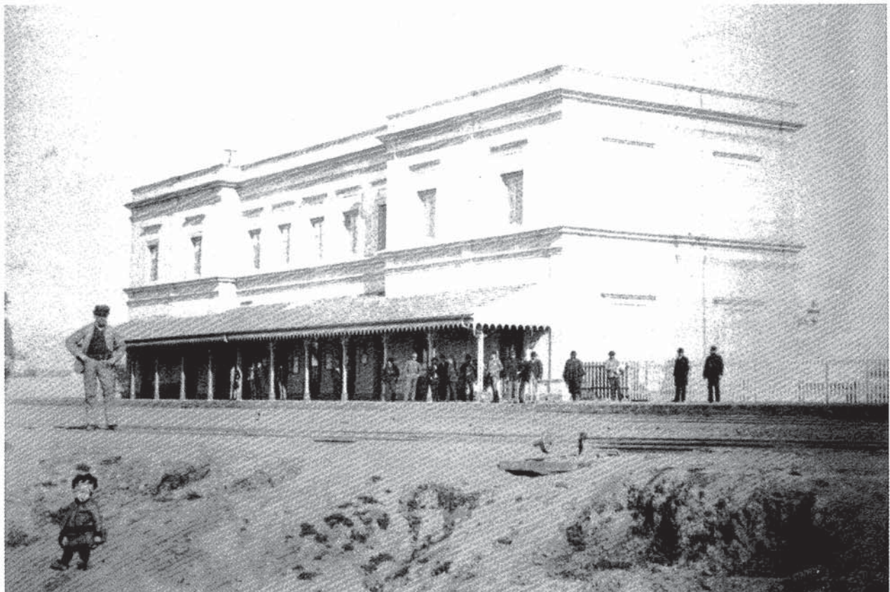
Estación de Santa Fe terminada (fachada a las vías)
