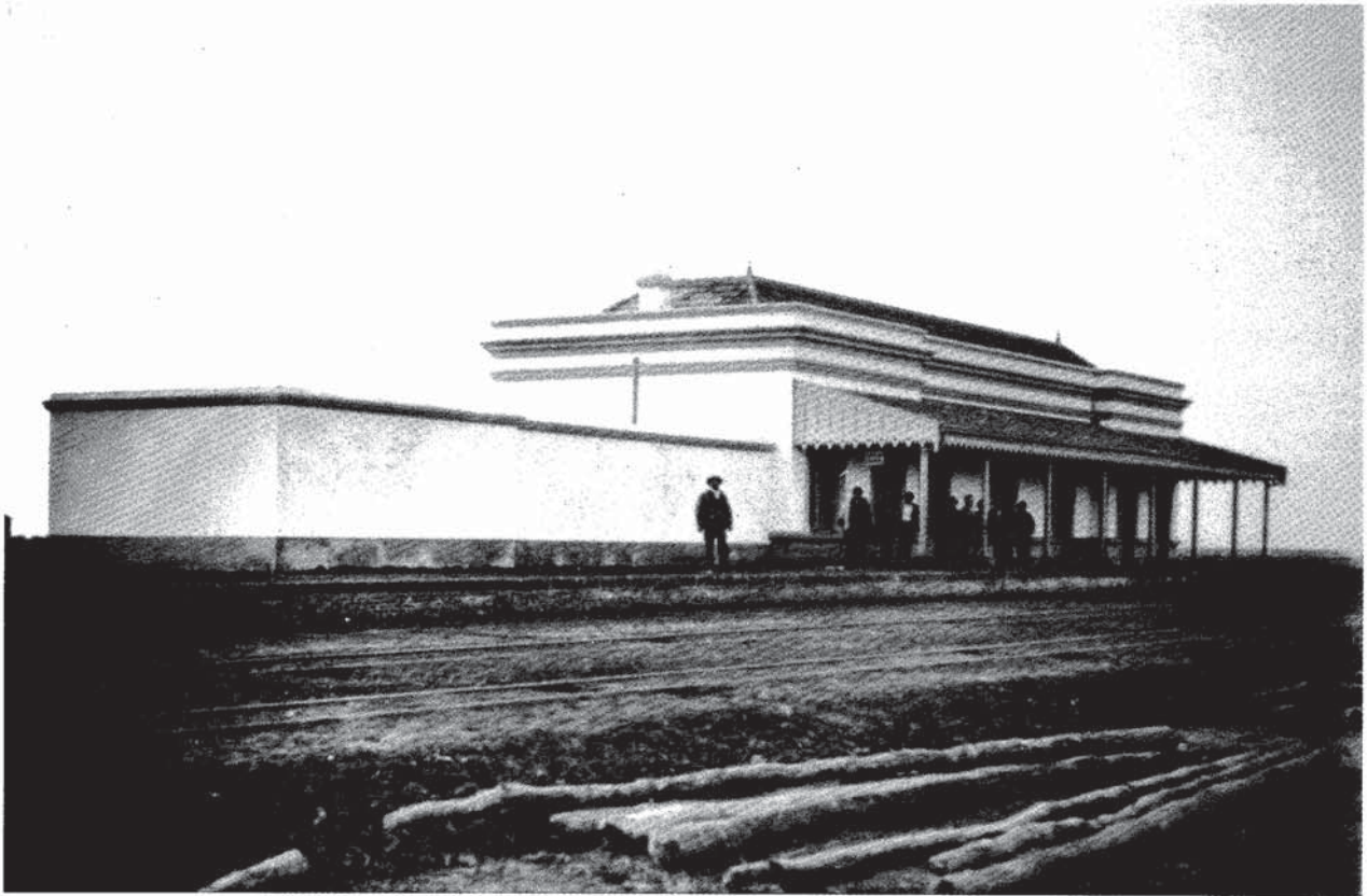
Estación Esperanza (vista a los andenes)
