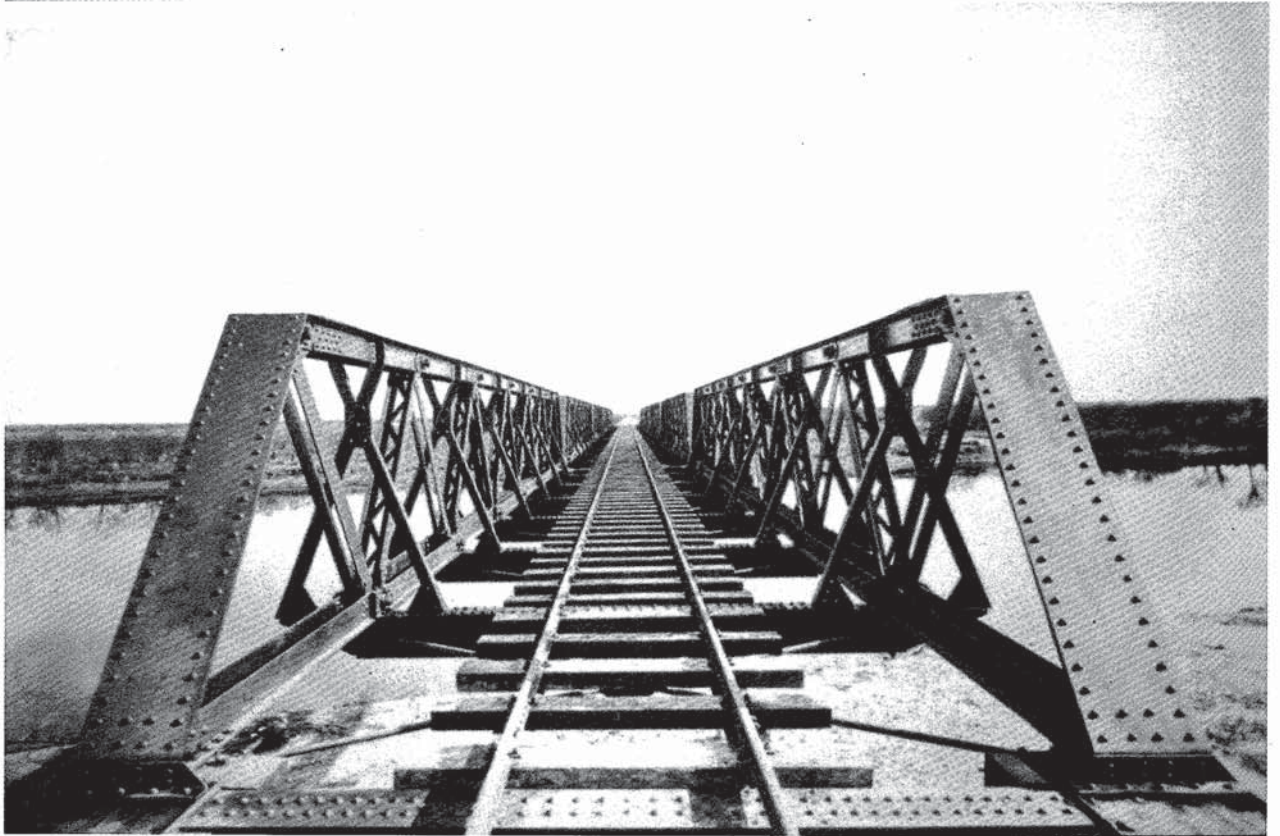
Puente sobre el Río Salado (100 mts. de luz)
