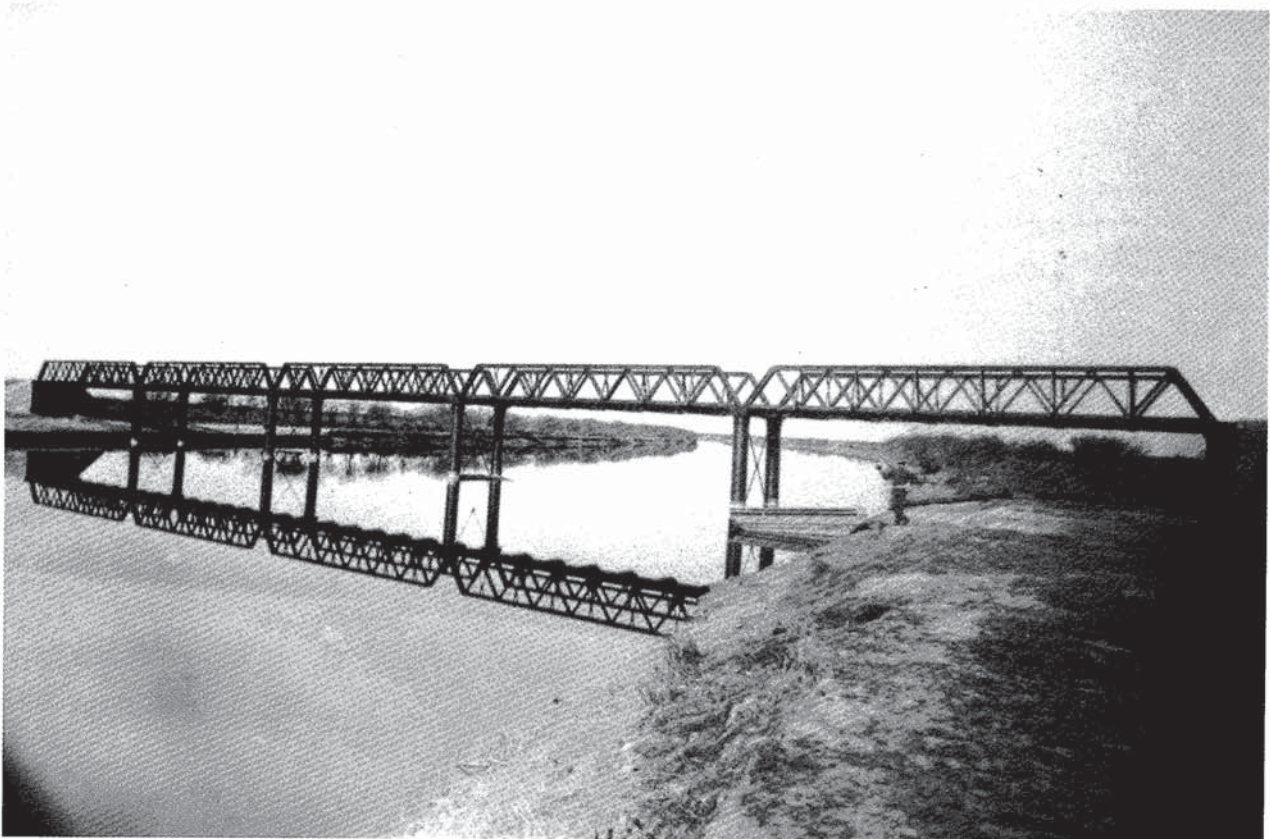
Puente sobre el Río Salado (100 mts. de luz)
