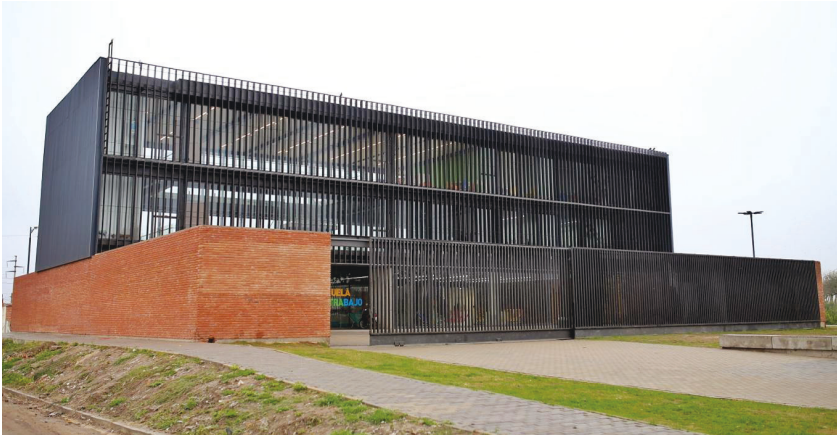
Figura 28. Ficha 184: Escuela de Trabajo Barranquitas Sur, Santa Fe. En un barrio en el que las carencias materiales se suman a la vulnerabilidad social se implanta una obra municipal de volúmenes simples, cuya expresión descansa en un contrapunto entre la materialidad del ladrillo y el metal, hecho que introduce cierta tensión en la sintaxis. La presencia del Estado municipal en sitios de alta demanda es una efectiva contribución a una mejor vida cívica a la cual contribuye la arquitectura.
