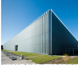
FICHA 240 - Edificio "Cero+Infinito" UBA - CABA
