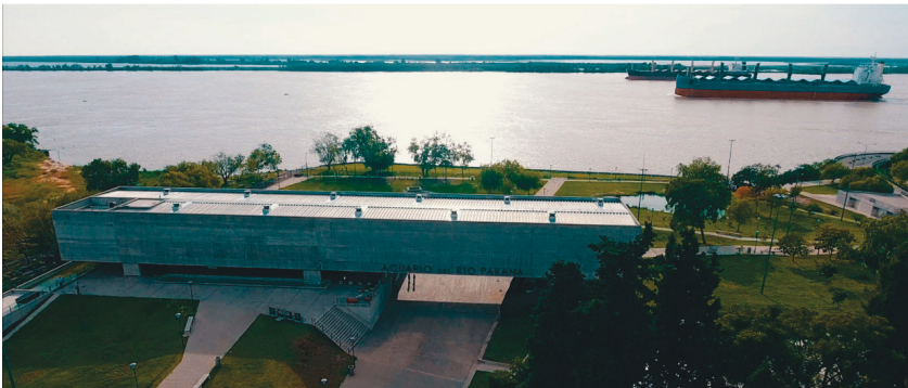
Figura 29. Ficha 224: Acuario del Río Paraná, Rosario. La referencia a la arquitectura brutalista basada en la expresión de la estructura y el uso del hormigón armado —la tradición paulista— es bastante directa en esta obra. Se trata de una forma prismática integral, apaisada de hormigón rústico, exenta y elevada, dispuesta en paralelo a la ribera del Paraná. Por debajo discurre el terreno natural, apenas parqueado, estableciendo un contrapunto entre el volumen hierático y el paisaje de costa.
