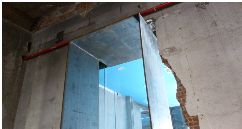
Figura 9. Detalla nave Espacio Intermediae. Fuente: Julio Arroyo.
