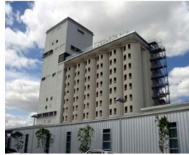
FICHA 215 - Hotel Los Silos. Casino. La Ribera - Santa Fe
