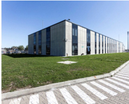
FICHA 132 - Edificio Administrativo Portuario - Berisso
