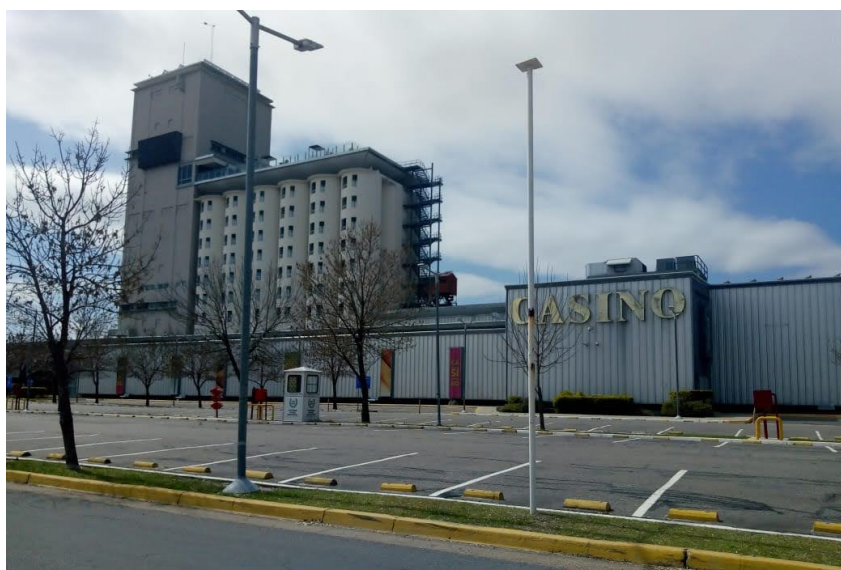
Figura 3. Silos reconvertidos: Hotel Los Silos y Casino. Foto: Autor.
