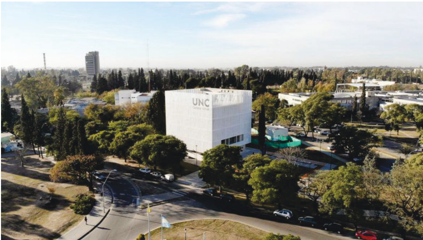
Figura 43. Ficha 226: Campus virtual de la Universidad Nacional de Córdoba. Deriva – Taller de Arquitectura. Un objeto cúbico, regular y blanco se destaca en el ingreso a la Ciudad Universitaria. Si bien la envolvente define su imagen integrada, ésta se recorta en proximidad al nivel de calle para establecer las necesarias articulaciones con el plano cero de la ciudad. Fuente: Summa+ N° 167.
