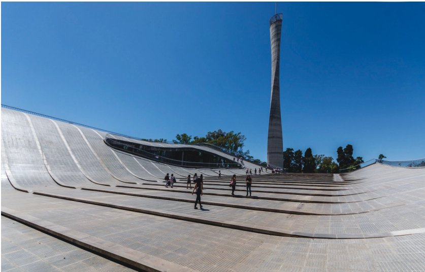
Figura 25. Ficha 90: Centro Cultural Córdoba y Archivo Histórico de la Provincia. Arquitectos Castañeda–Cohen–Nanzer–Saal–Salassa–Tissot. Una lámina ondulatoria determina unos espacios fluidos que han sido colonizados con distintos usos interiores (archivos, exposiciones, auditorio) en tanto que el exterior se ofrece como un lugar público extraordinario por lo atípico de la forma, que induce a apropiaciones lúdicas. El elemento escultórico a modo de faro jalona el conjunto que ocupa parte de un tradicional parque de la ciudad.
