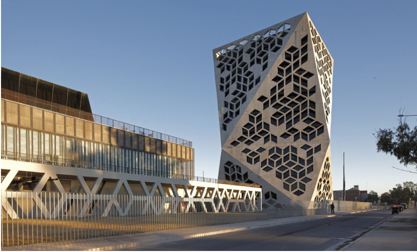
Figura 6. Centro Cívico del Bicentenario. Córdoba. Envolventes caladas. Lucio Morini y GGMPU Arquitectos.
