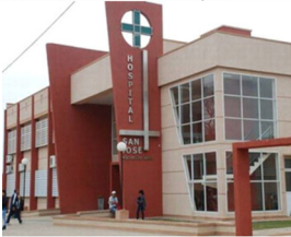
FICHA 73 - Nuevo Hospital San José - Paso de los Libres
