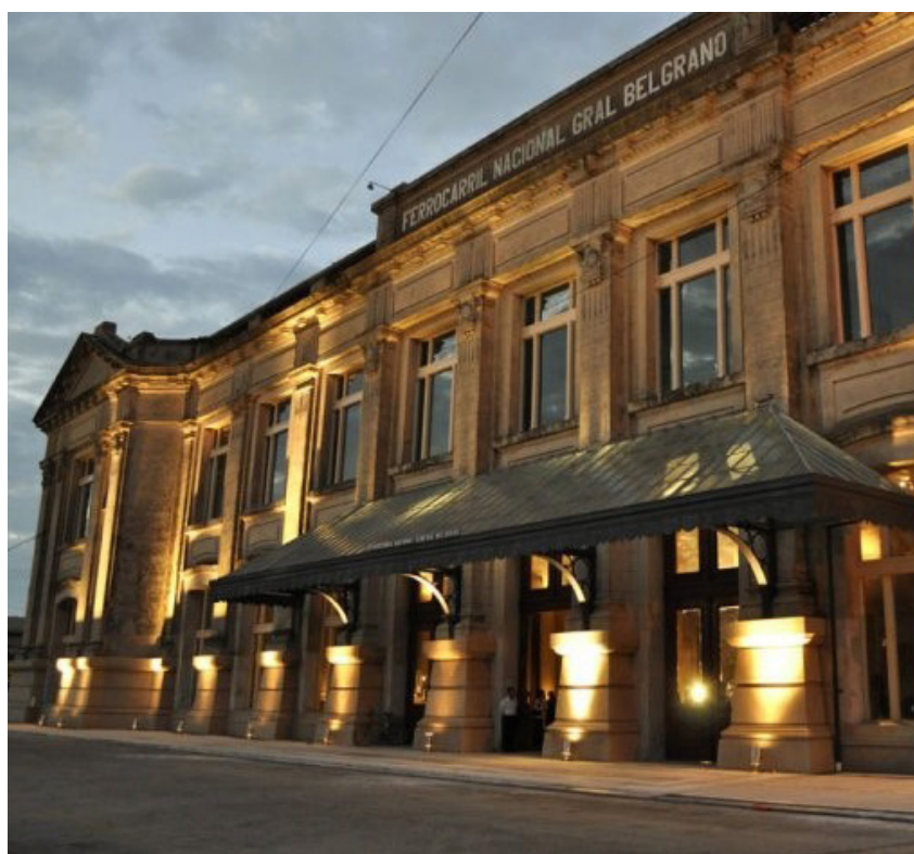
Figura 9. Ex estación del FF.CC. Gral. Manuel Belgrano rehabilitada. Santa Fe.
