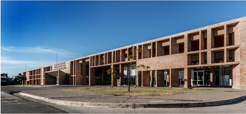
Figura 34. Ficha 94: Hospital del Sur Príncipe de Asturias. Arquitectos Alejandro Paz, Ian Dutari y Santiago Viale. Córdoba. La planta del hospital responde edificio de cabecera dispuesto en paralelo a la calle y que genera el frente urbano, que vincula un sistema de cuerpos paralelos perpendiculares al principal. La imagen urbana se basa en una reinterpretación del concepto del brise-soleil mediante un juego de planos verticales y horizontales que generan sobras y transparencia, ocasionalmente interrumpida por el cierre de algunos vacíos. La expresión del conjunto es de dinamismo y sutileza, reforzada por la materialidad del ladrillo.
