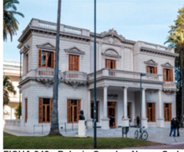
FICHA 242 - Palacio Canals - Nueva Sede IAPOS - Rosario
