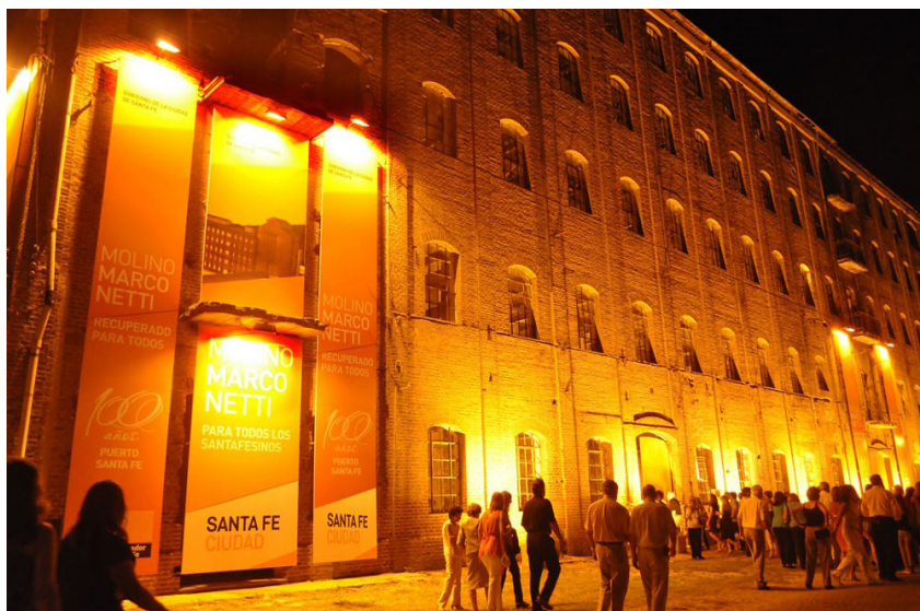
Figura 10. Ex Molino Marconetti en el área de renovación portuaria. Santa Fe.
