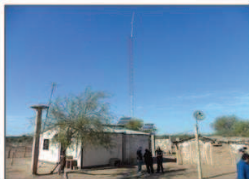
Foto N° 6: muestra la antena de radio VHF y el tipo de casa en la zona de Pozo Redondo – Familia Ledesma.
