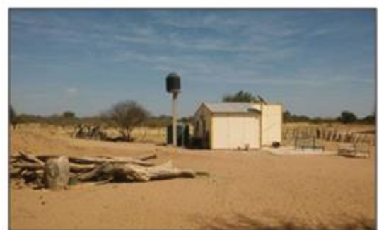
Foto N°2: muestra el estado de las viviendas proyecto de erradicación de ranchos- Los Mistoles
