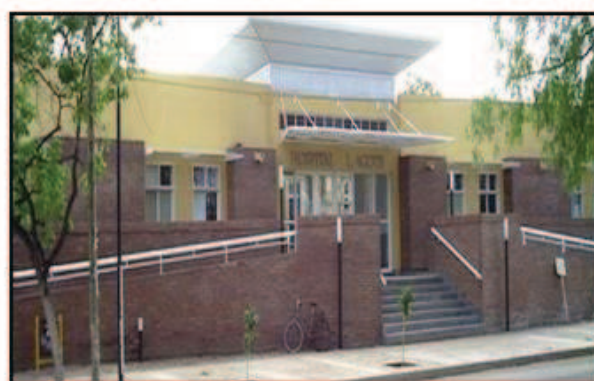
Foto N° 7: muestra la fachada del Hospital Zonal Luis Agote del Depto. Chamental
