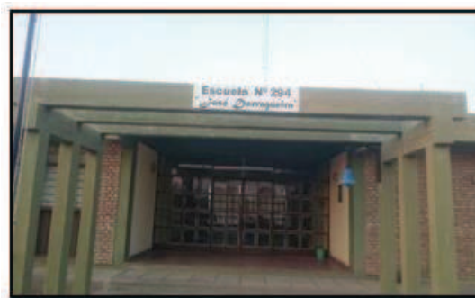
Foto N° 8: muestra la fachada de ingreso a la escuela del Retamo.
