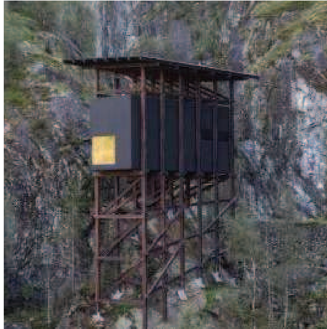
Figura 04: Zumthör Peter. Museo de la Mina de Zinc Allmannajuvet. Sauda. Noruega. 2016. Fuente: Plataforma Arquitectura. https://www.plataformaarquitectura.cl/cl/797003/museo-de-la-mina-de-zinc-allmannajuvet-peter-zumthor/57ed0a48e58ece20450001a0-allmannajuvet-zinc-mine-museum-peter-zumthor-photo
