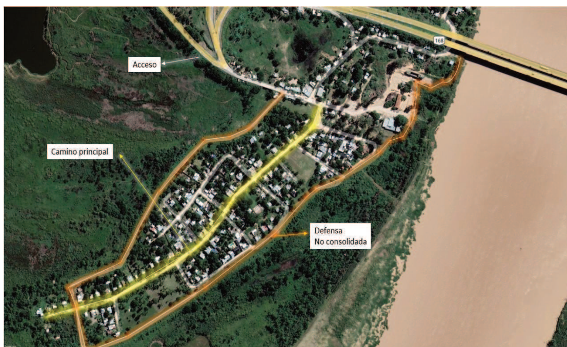
Figura 24. Sector sur del Barrio Colastiné Sur. Delimitación aproximada de las defensas. Fuente: Elaboración propia.
