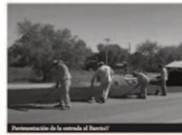
Pavimentación de la entrada al Barrio
