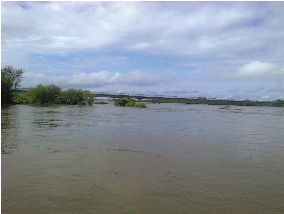
Figura 33. El Corte Grande en la inundación 2015 - 2016. Se observa el Puente peatonal y bajo agua la calle por la que acceden los vehículos a La Boca. Fuente: Registro personal EB1.
