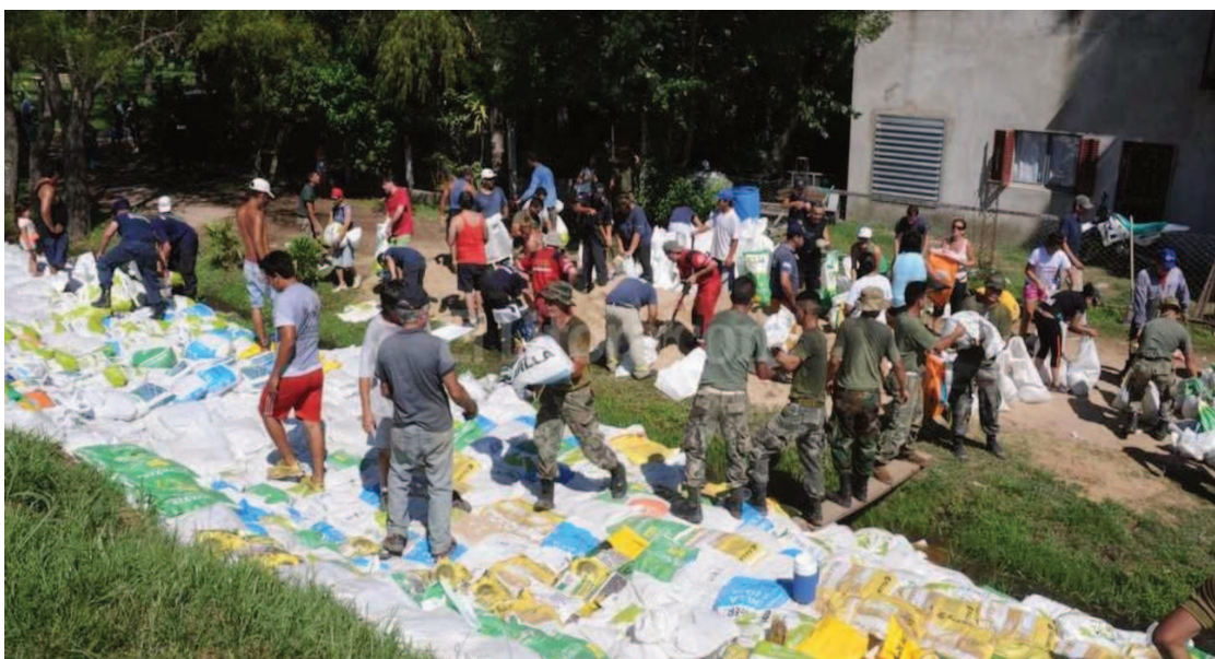
Figura 31. Protección de la defensa después de la alarma de ruptura. Fuente: El Litoral 02/01/2016.
