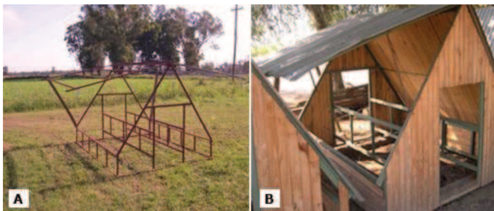
Figura 9. (A) Estructura de armazón de hierro y (B) sistema de apertura de techos para circulación del aire de las parideras a campo empleadas en el SC.
