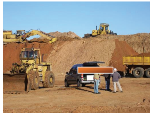
Fotografía 5. Máquinas trabajando en cantera de extracción de áridos.
