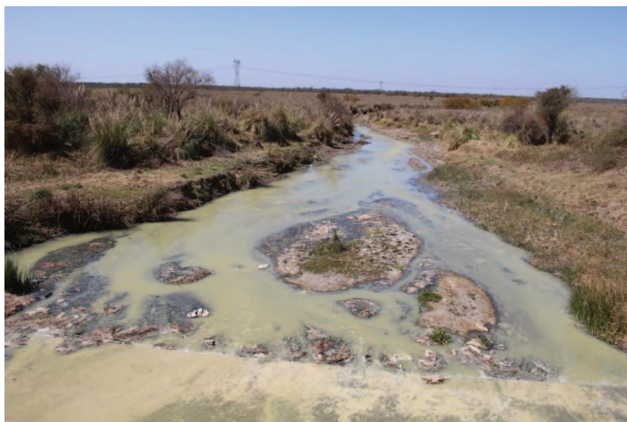
Figura 3.13: Vista hacia aguas abajo del puente carretero RP50S.
