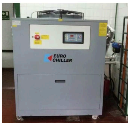
Figura 6. Imagen correspondiente al módulo de refrigeración marca Euro Chiller, acoplado al equipo APH.
