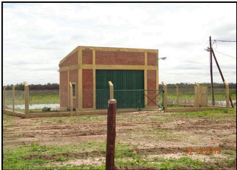
Figura N° 4.29. Casilla bombeo embalse Ibarreta
