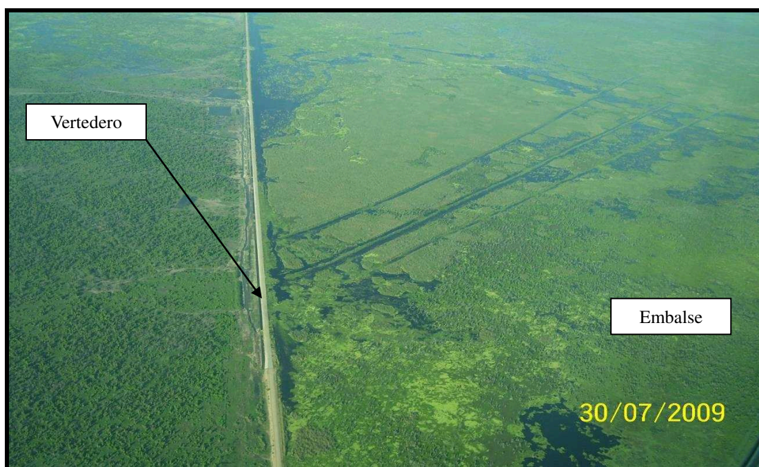
Figura N° 6.24. Vertedero y Embalse RP N° 28, vista área.
