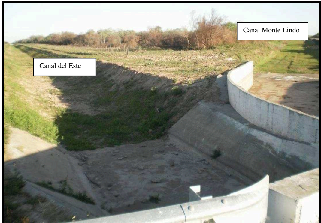
Figura N° 4.9. Obra partidora (canal Monte Lindo, del Este-vista hacia aguas abajo)
