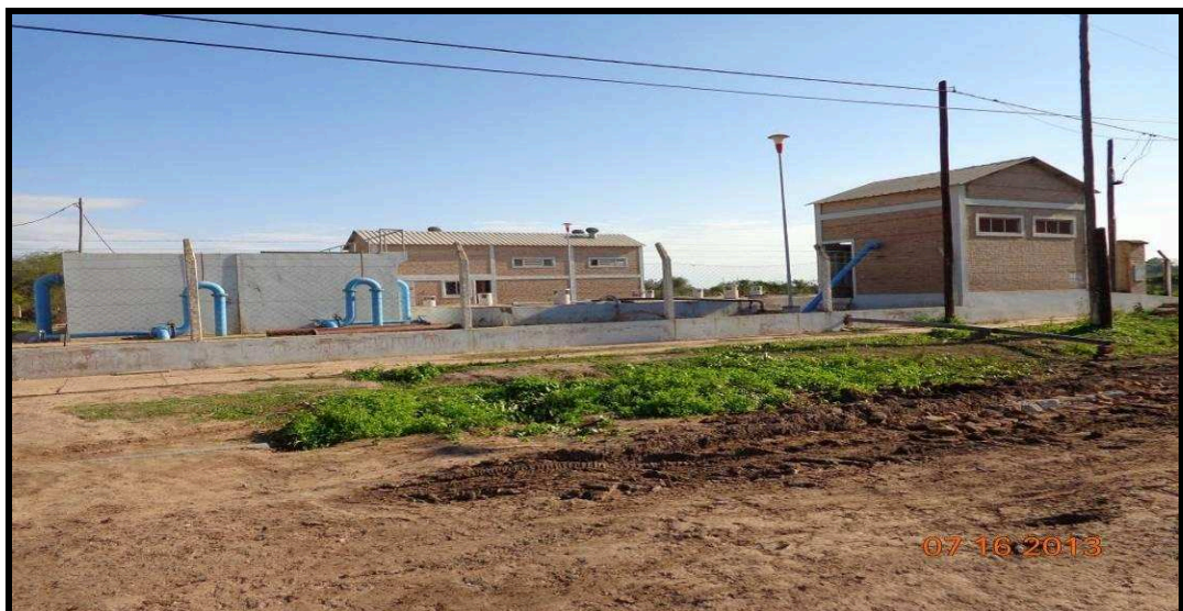
Figura N° 4.23. Planta de agua potable Estanislao del Campo
