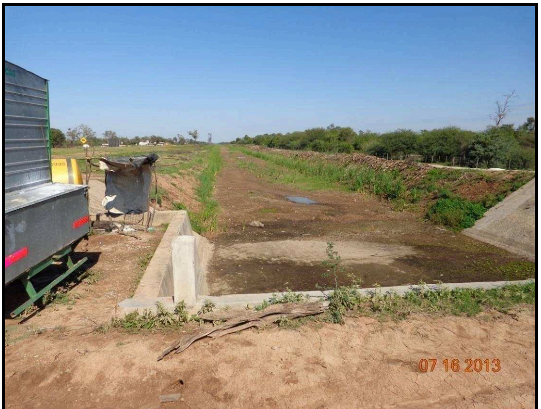
Figura N° 4.11. Canal Las Lomitas (vista hacia aguas abajo)
