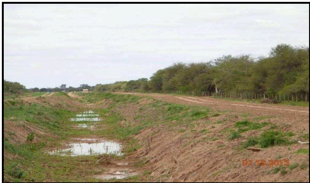
Figura N° 4.27. Canal Monte Lindo-embalse Ibarreta (vista hacia aguas abajo)
