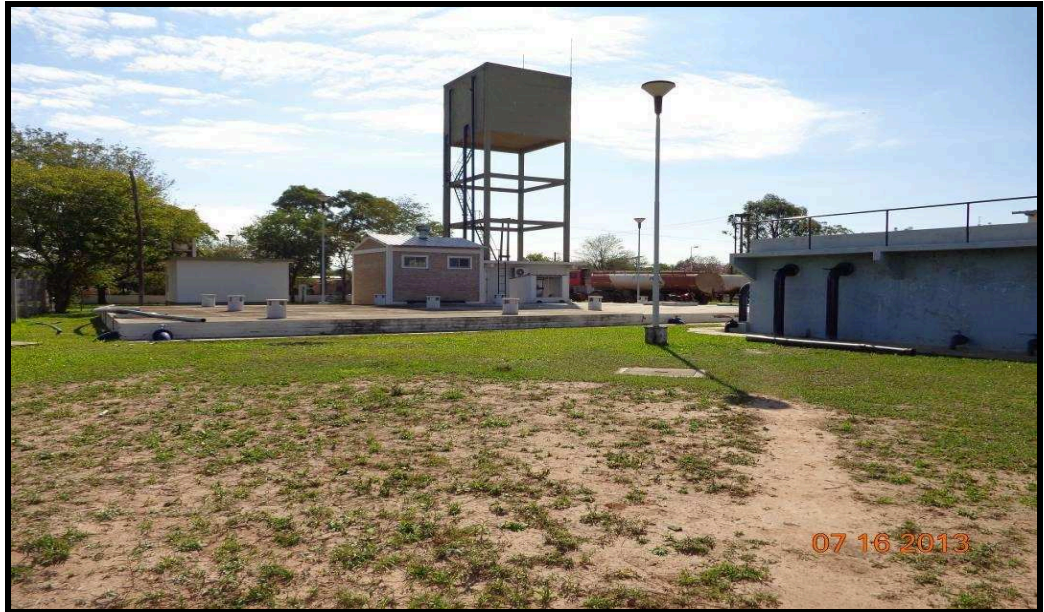
Figura N° 4.19. Planta de agua potable Pozo del Tigre (tanque de distribución)
