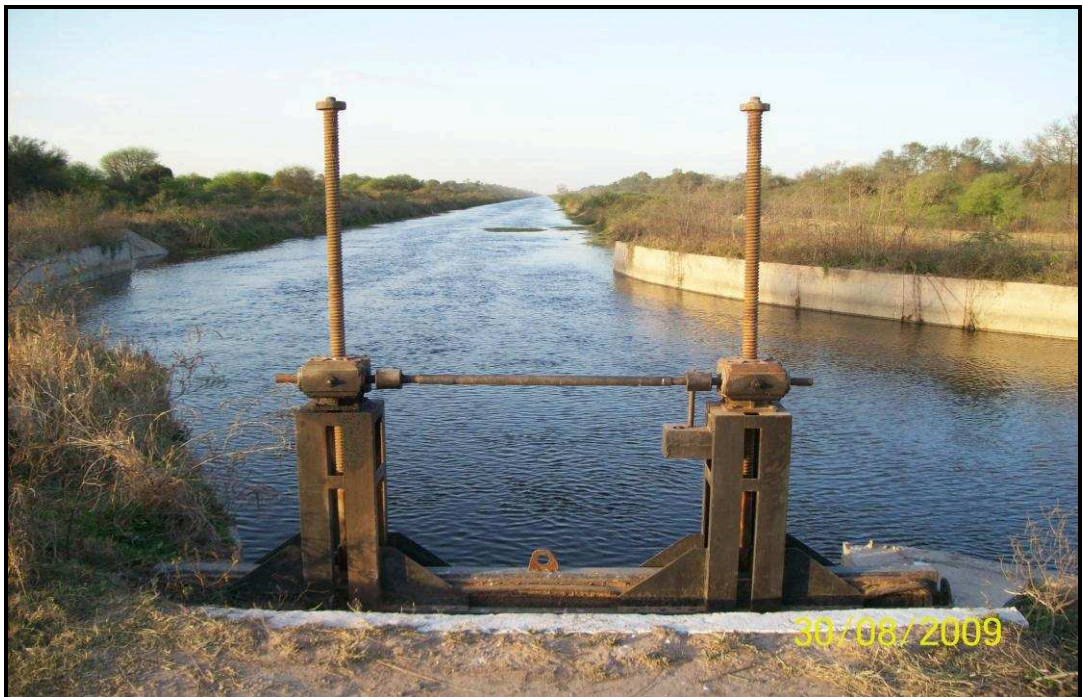
Figura N° 4.7.Canal Embalse RP N° 28-obra partidora (vista hacia aguas arriba)
