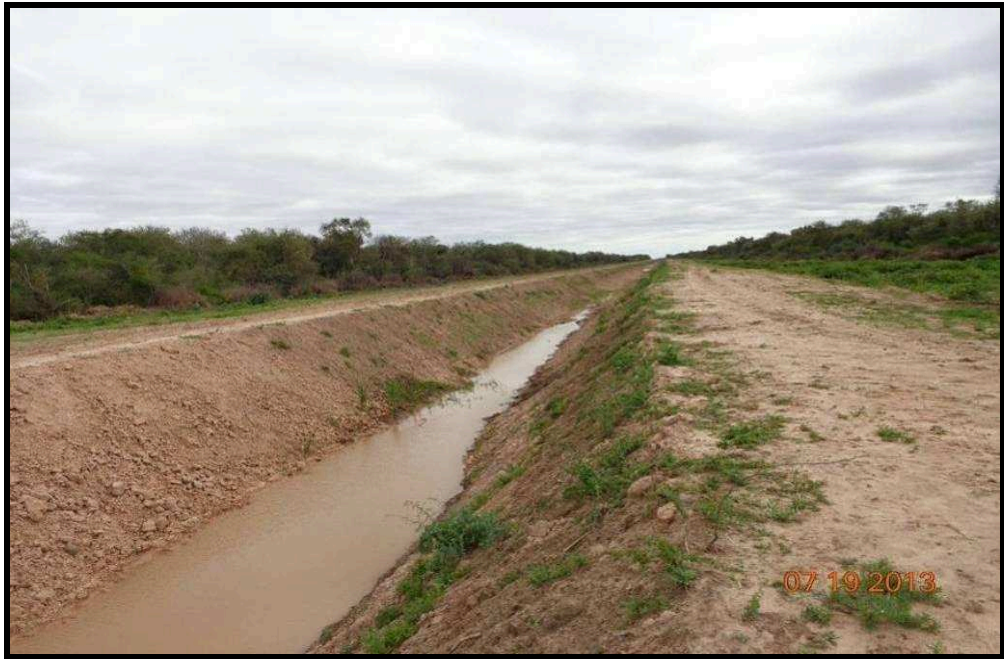
Figura N° 4.28. Canal Monte Lindo-embalse Ibarreta (vista hacia aguas arriba)
