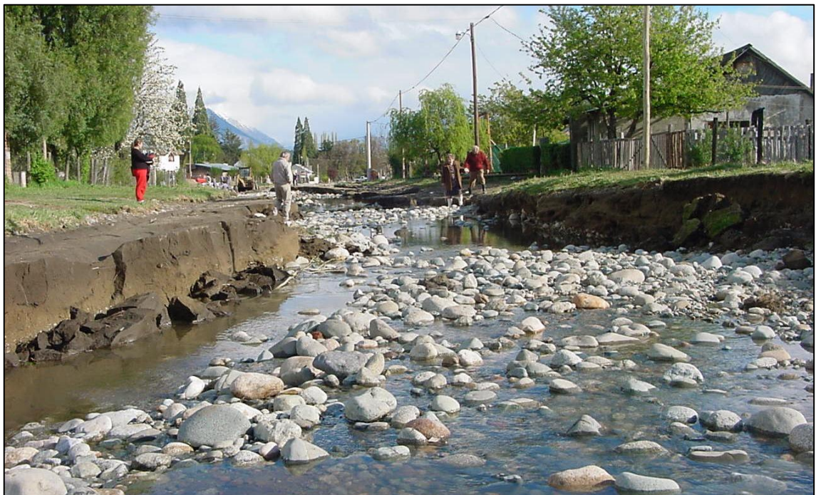
Figura 10.1 Arroyo urbano debido a brecha en la defensa de margen izquierda del río Quemquemtreu
