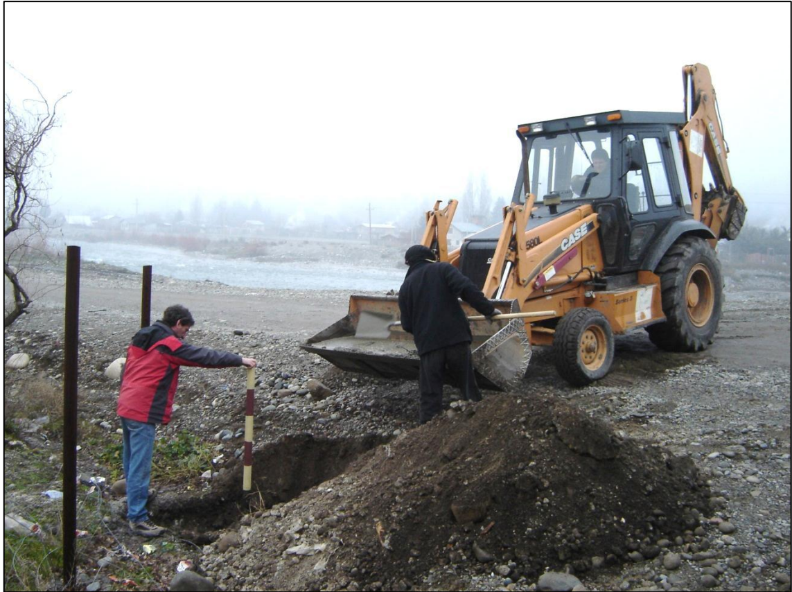
Figura 9.4 Colocación de mojones indicativos de la ubicación de la línea de ribera, sobre la margen izquierda del río Quemquemtreu (24/07/2008)
