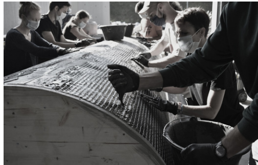
FIGURA 11 | Taller de verano «Prototype Pavilion in Textile Reinforced Concrete», 2019, EPFL Fotografía: Ana Carvalho.
