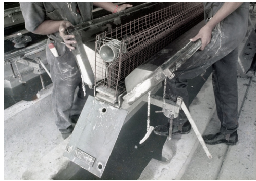
FIGURA 1 | Encofrado y armadura de piezas en argamasa armada – viga de las «Escolas Transitórias» (1988). Fuente: Instituto João Filgueiras Lima.
