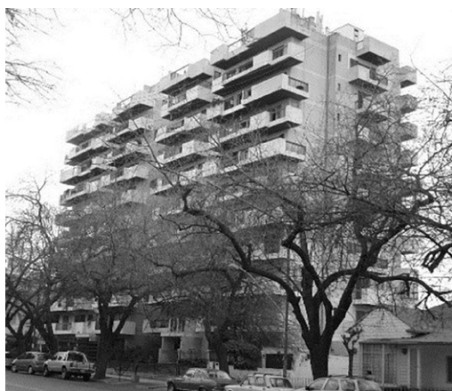
FIGURA 10 | Edificio de 10 niveles de tipología en torre, ubicado en avenida Emilio Civit 435. Arquitecto Jacques Caspi (1985). Fuente: Raffa (2017:103).
