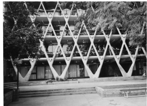
FIGURA 9 | Edificio de la Facultad de Arquitectura de la Universidad de Mendoza, estructura a la vista que evoca figuras humanas enlazadas. Fuente: fotografía de la autora.
