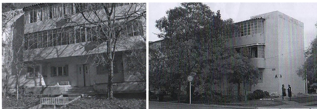
FIGURA 4 | Imágenes de fachadas y volumetría de las viviendas colectivas (1937) que constituyen el actual barrio Cano. Fuente: Ponte (2008:401 y 403).
