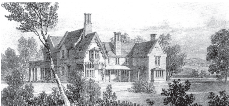
FIGURA 15 | Casa em estilo de antigo solar. Em Deisgns for ornamental villas, Inglaterra, P. F. Robinson, 1827. Fonte: ACKERMAN, 1997, p. 263.
