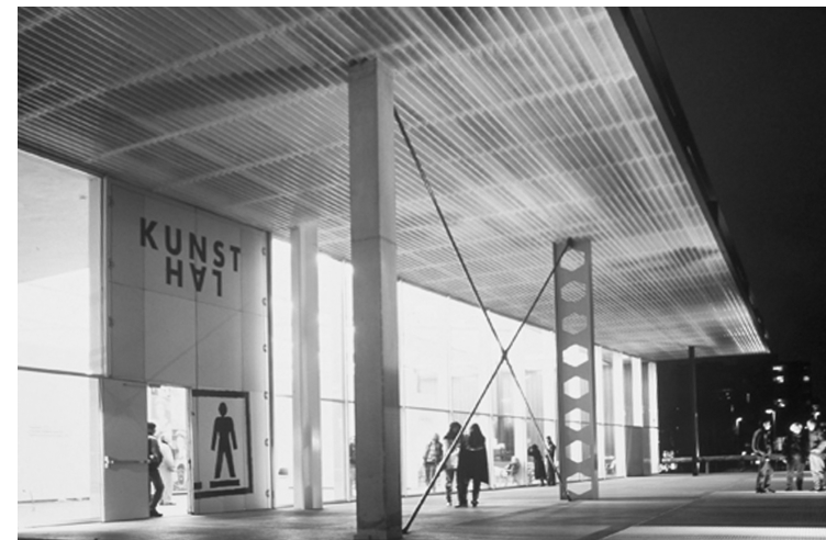
FIGURA 10 | Detalle de las columnas de acceso y los arriostramientos laterales del edificio. Kunsthall, Rotterdam.
