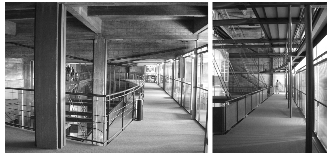
FIGURA 7 | Fotos de la intervención.
