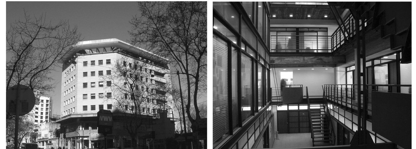
FIGURA 4 | Fotos de la intervención.
